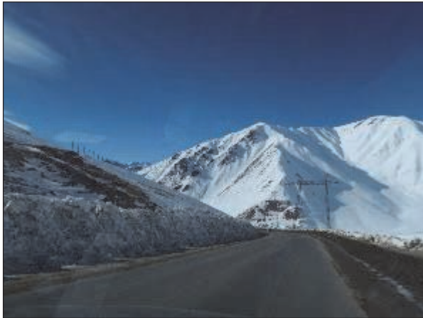
起点側からの鋭角な風向による小規模な吹きだまりが発生した痕跡がある（図 2-2-4.4 (3)の p）。
