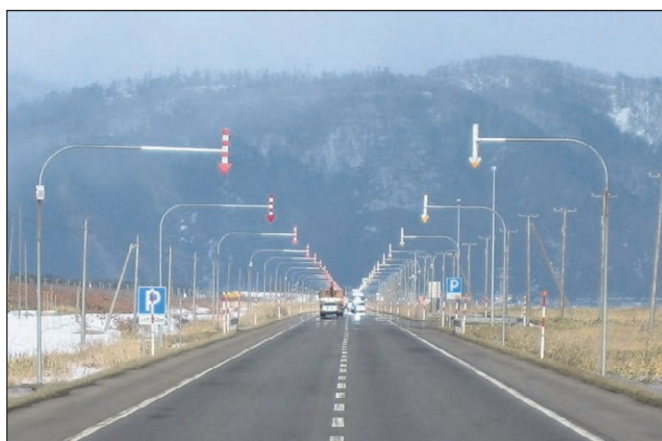
写真 3-2-2.2 視線誘導柱の設置例（視線誘導対策）
