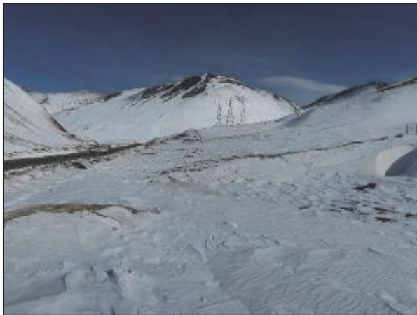
道路に対して鋭角また平行な風向による吹雪発生痕跡がある（図 2-2-4.4 (3)の r）。
