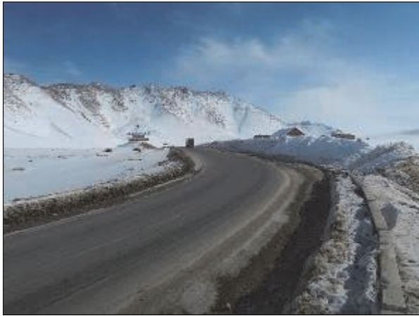
風上側に除雪による大きな雪堤があり、吹きだまりの影響を受けている可能性が高い（図 2-2-4.4 (1)の a）。
