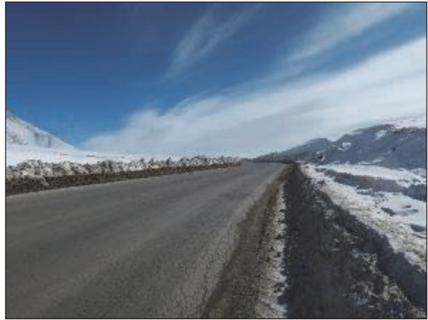
路側の切土斜面に吹きだまりを生じた痕跡がある（図 2-2-4.4 (1)の g）。
