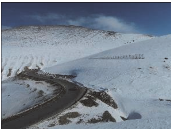
谷地形の起点側では斜面に沿って大規模な吹きだまりが成長している（図 2-2-4.4 (1)の i）。
