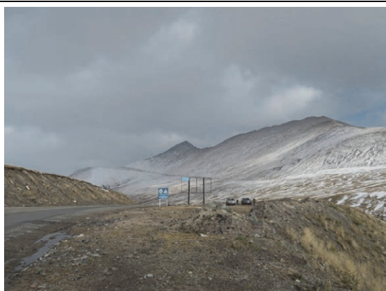
KP215+850 南からの河川に沿った谷地形が広がり、地吹雪の影響を受けやすい地形となっている
