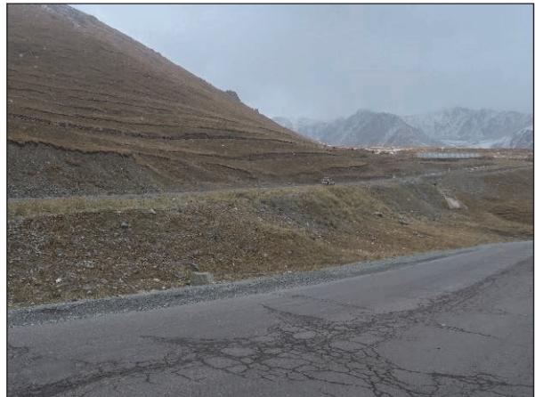
KP 127+400 南側に平坦な地形が広がり、地吹雪の影響を受けやすい地形となっている。
