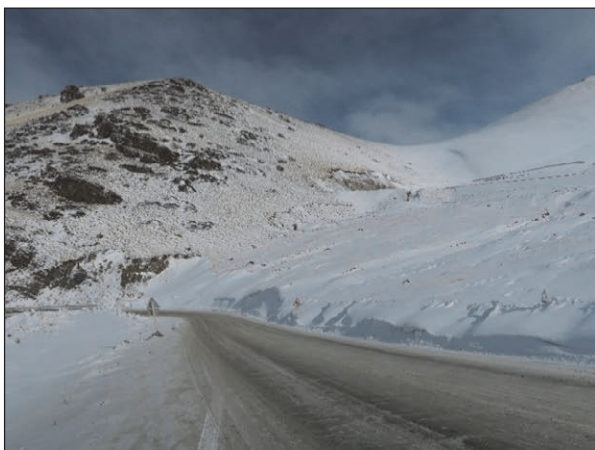
路側に連続した吹きだまりが発生している（図 2-2-4.3 の g）。
