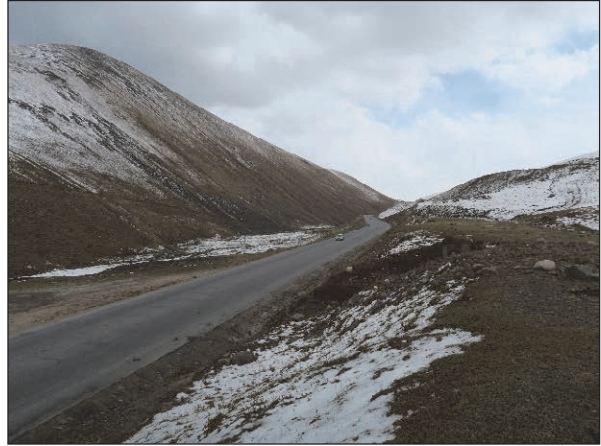
KP 219+250 道路南側の切土斜面の背後に平坦地が広がり、地吹雪の影響を受けやすい。
