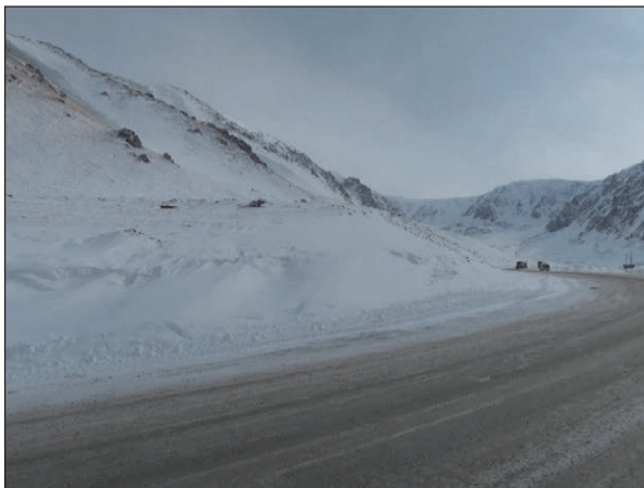
路側の吹きだまりは道路線形に応じて、道路に鋭角な方向で生じている（図 2-2-4.3 の k）。
