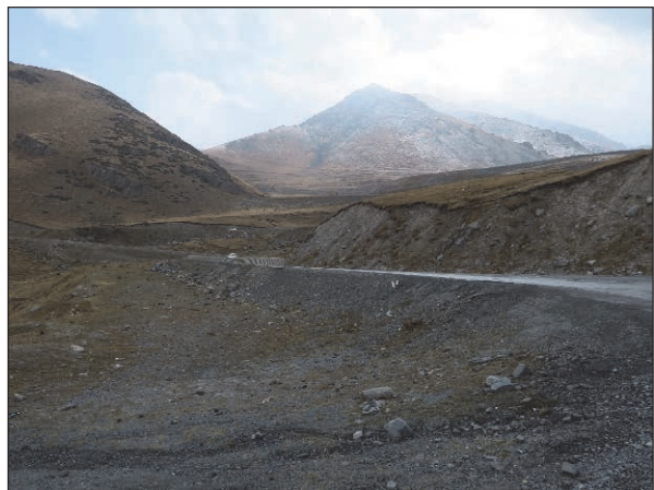
KP 125+400 切土斜面が大きくかつ急傾斜であり、背後の平坦地も大きく、吹きだまりの要因となりうる。
