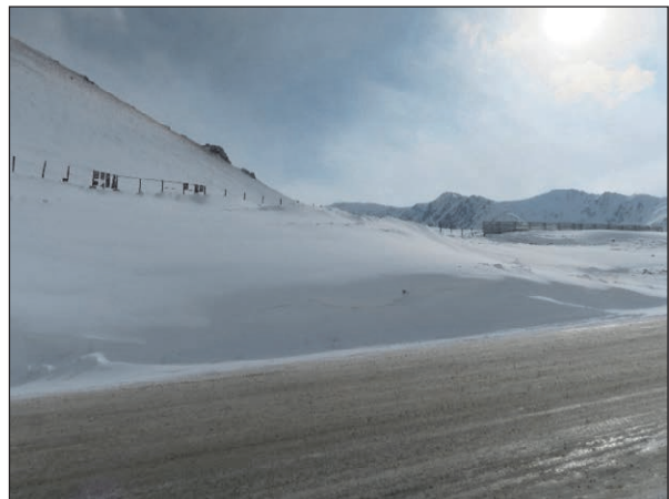
道路の山側に規模の大きな吹きだまりが連続的に発生している（図 2-2-4.3 の i）。
