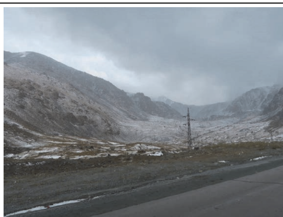
KP128+200 南南東方向に平坦な谷地形が広がり、地吹雪の発生域となっている可能性が高い
