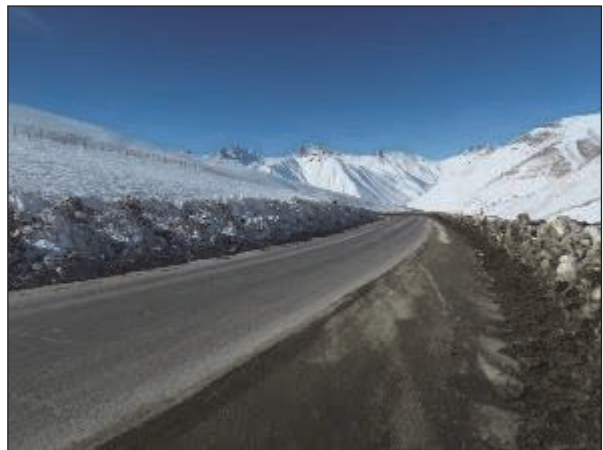
カーブに従って主風向との角度が大きくなり、道路上に吹きだまりを生じた痕跡が見られる（図 2-2-4.4 (1)の h）。
