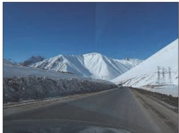
山側の切土斜面に沿って小規模な吹きだまりが連続的に発生した痕跡がある (図 2-2-4.4 (2)の o)。
