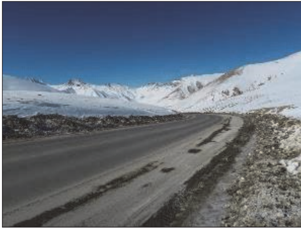
道路に対して鋭角な方向で小規模な吹きだまりが生じた痕跡がある（図 2-2-4.4 (1)の f）。
