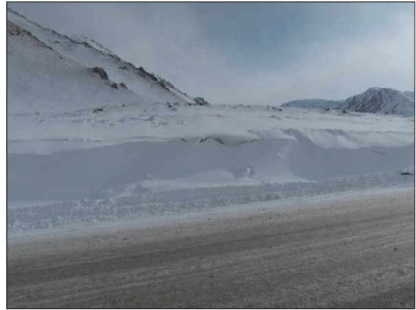
山地側の平坦地を供給源とする吹きだまりが連続的に発生し、一部は雪庇状になっている（図 2-2-4.3 の k）。
