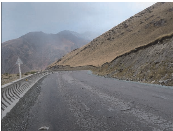
KP 125+050 山地斜面側に急傾斜の切土斜面があり、吹きだまり発生の要因となっている。
