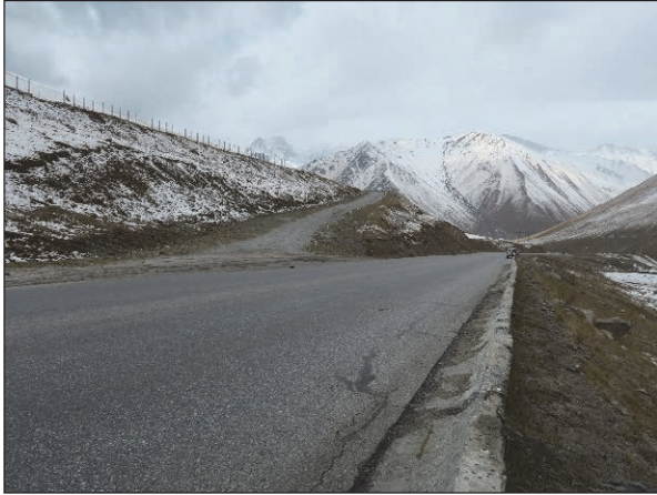
KP 218+750 道路南側の切土斜面の背後に平坦地が広がり、地吹雪の影響を受けやすい。
