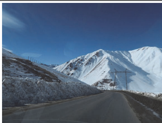
KP220+150 起点側からの鋭角な風向による小規模な吹きだまりが発生した痕跡がある
