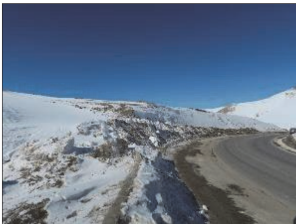
カーブ区間の終点側の切土斜面には吹きだまりが生じた痕跡がある（図 2-2-4.4 (1)の d）。
