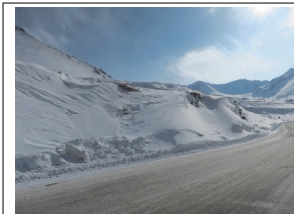
KP126+000 斜め方向からの吹きだまりが路側に発生している
