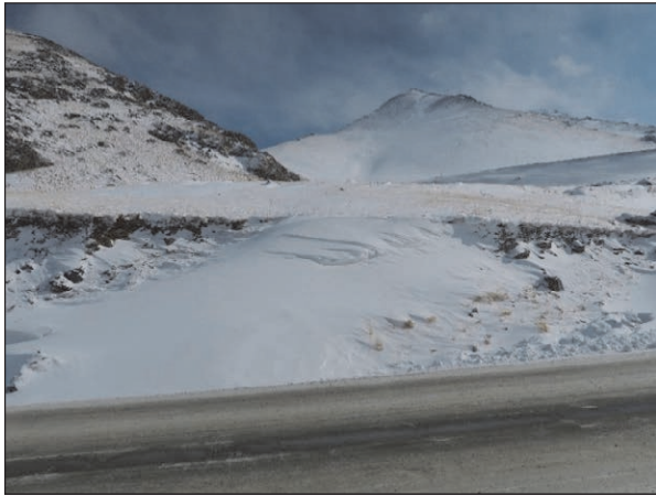
風上側の平坦地を供給源とする吹きだまりが路側に成長している（図 2-2-4.3 の d）。
