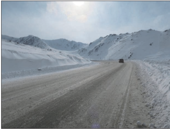
山地側の平坦地を供給源とする吹きだまりが連続的に発生し、一部は雪庇状になっている（図 2-2-4.3 の k）。
