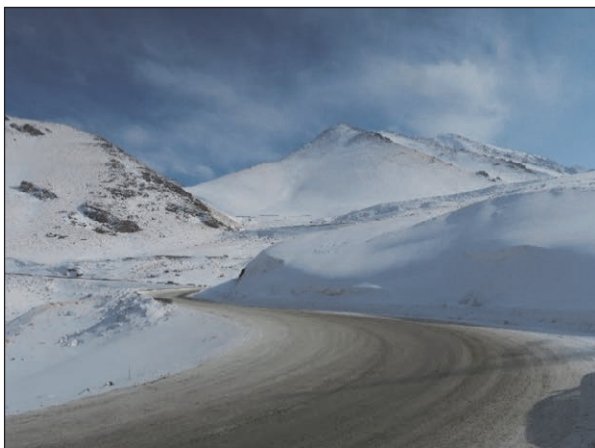
切土斜面に大きな吹きだまりが形成されている (図 2-2-4.3 の c)。
