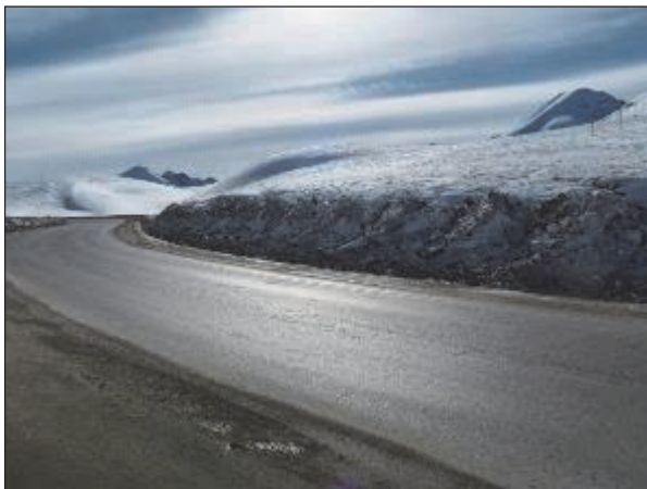
カーブに従って主風向との角度が大きくなり、道路上に吹きだまりを生じた痕跡が見られる（図 2-2-4.4 (1)の h）。
