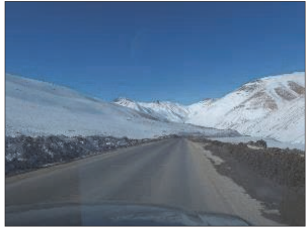
道路の山側から小規模な吹きだまりが発生した可能性がある (図 2-2-4.4 (2)の l)。
