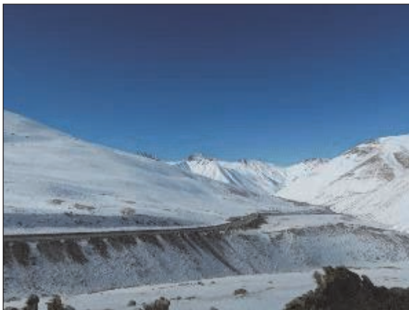
道路の南側には広大な平坦地があり、切土区間では吹きだまりの影響を受ける可能性が高い (図 2-2-4.4 (2)の l を遠望)。
