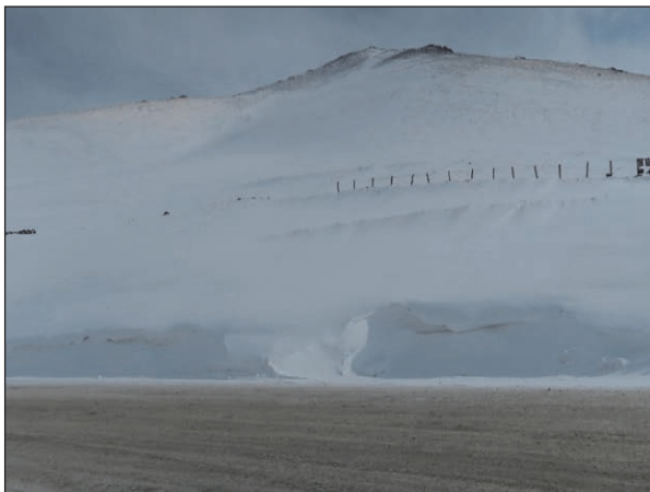
道路の山側に規模の大きな吹きだまりが連続的に発生している（図 2-2-4.3 の i）。
