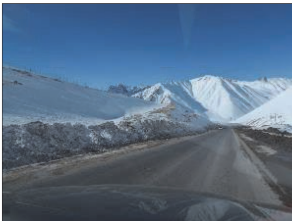
切土斜面では山側から小規模な吹きだまりが発生した痕跡が見られる (図 2-2-4.4 (2)の n)。
