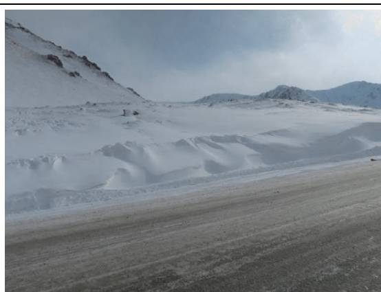
KP128+300 風上側の平坦地から発生した吹きだまりが道路側に成長している
