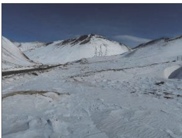
道路に対して鋭角また平行な風向による吹雪発生痕跡がある（図 2-2-4.4 (3)の r）。
