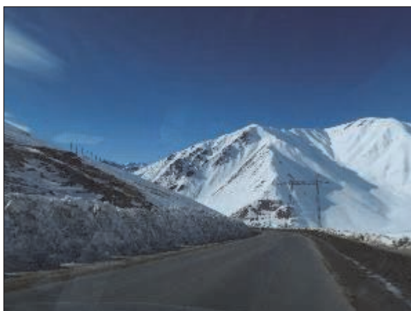
起点側からの鋭角な風向による小規模な吹きだまりが発生した痕跡がある（図 2-2-4.4 (3)の p）。
