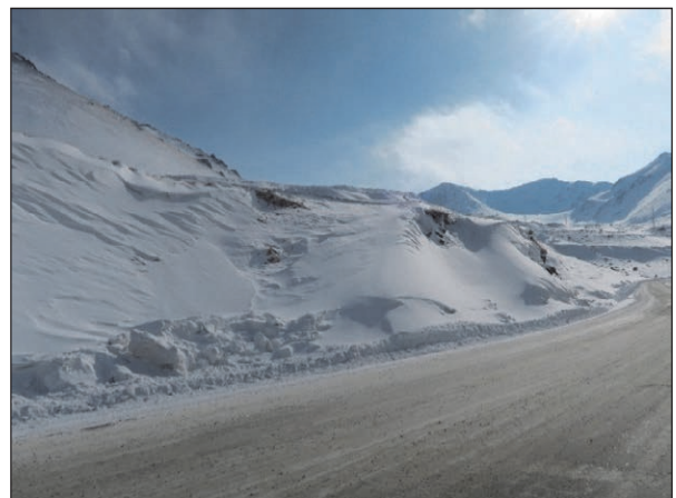
斜め方向からの吹きだまりが路側に発生している (図 2-2-4.3 の d)。
