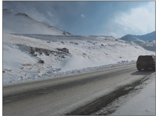
やや鋭角な風向による小規模な吹きだまりが発生している（図 2-2-4.3 の e）。
