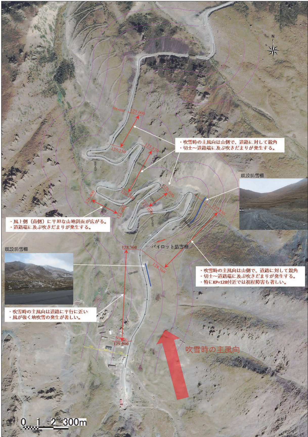
図 2-2-2.2 地吹雪による通行障害区間（Too-Ashuu 峠）
