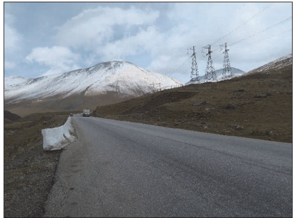
KP 221+250 道路の東方向には坦な地形が連続し、地吹雪の発生源となっている。
