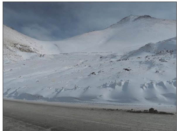
道路付近に吹きだまりは生じていないが、風上側の平坦地には吹雪の痕跡が残り、視程障害を生じやすいことが推察できる（図 2-2-4.3 の f）。
