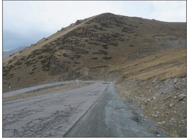
KP 127+50 平坦な山地斜面が南側に広がり、地吹雪の影響を受けやすい地形となっている。
