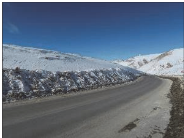
道路に対して鋭角な方向で小規模な吹きだまりが生じた痕跡がある（図 2-2-4.4 (1)の e）。
