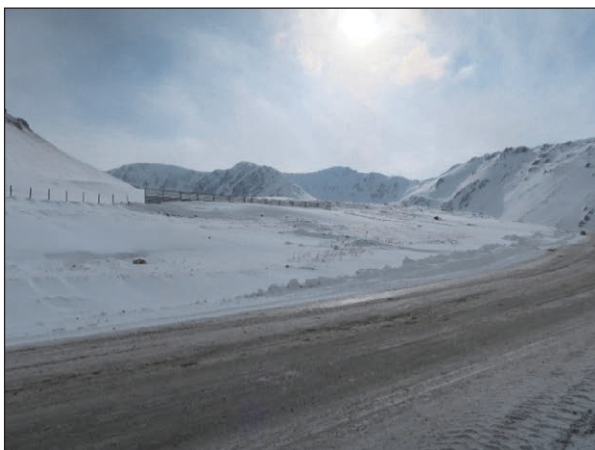
パイロット柵の風下側では吹きだまりの規模は小さい（図 2-2-4.3 の j）。
