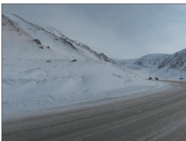
路側の吹きだまりは道路線形に応じて、道路に鋭角な方向で生じている（図 2-2-4.3 の k）。
