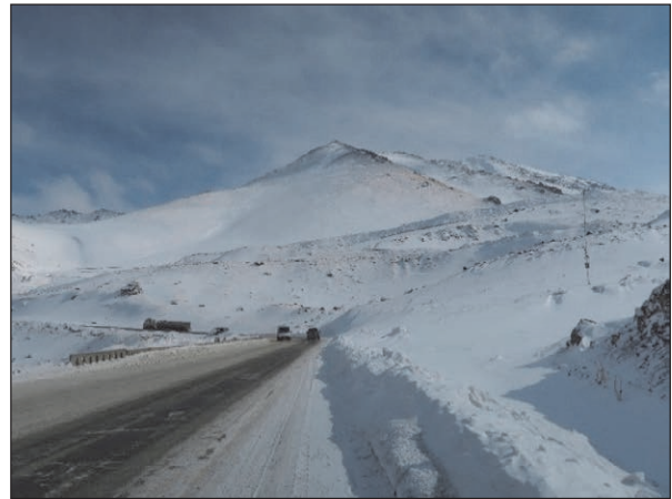
道路付近に吹きだまりは生じていないが、風上側の平坦地には吹雪の痕跡が残り、視程障害を生じやすいことが推察できる（図 2-2-4.3 の f）。
