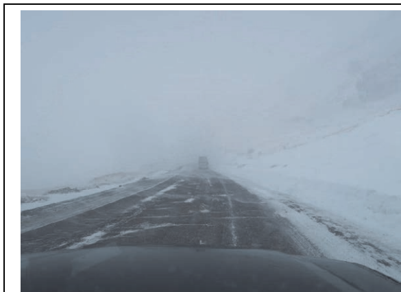
KP126+150 地吹雪による視程障害の発生状況
