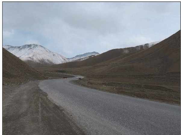
KP 222+000 道路の周囲に平坦地が広がり、地吹雪による吹きだまりや視程障害が発生しやすい。
