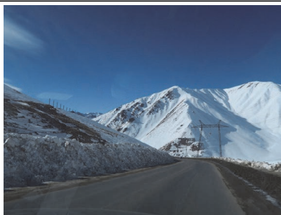
KP220+150 起点側からの鋭角な風向による小規模な吹きだまりが発生した痕跡がある
