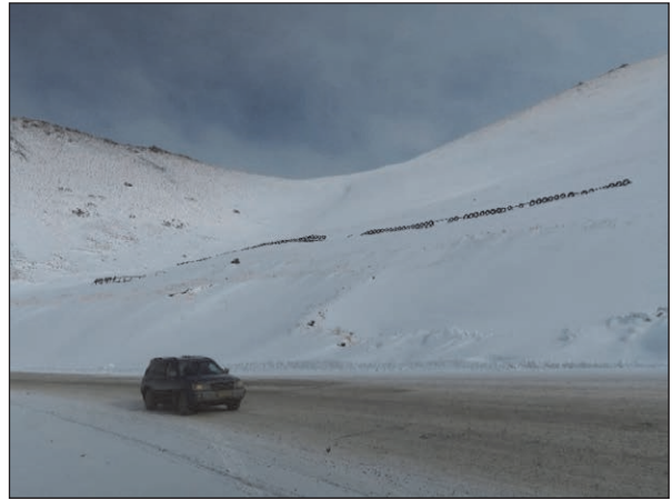
路側に連続的に規模の大きな吹きだまりが発生している（図 2-2-4.3 の i）。
