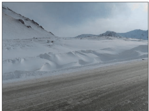
風上側の平坦地から発生した吹きだまりが道路側に成長している（図 2-2-4.3 の k）。
