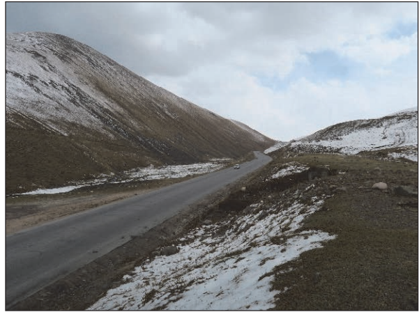
KP 219+250 道路南側の切土斜面の背後に平坦地が広がり、地吹雪の影響を受けやすい。
