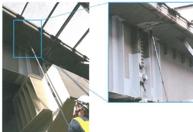
打音検査システム使用状況
