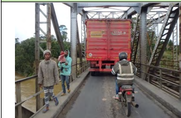
Situation de la circulation de piétons sur le pont. Aucun dégagement latéral entre la chaussée et le trottoir n'est prévu.
