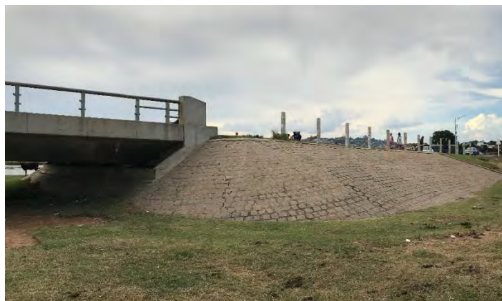
Figure 2-32 Image du revêtement des rives du pont d'Antsapazana
