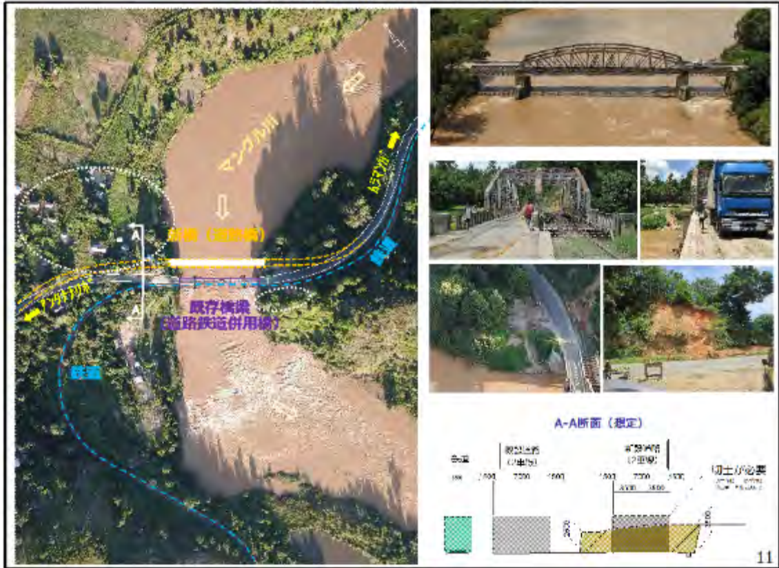
マングル橋 (国道2号線 PK94+200) 周辺状況写真
