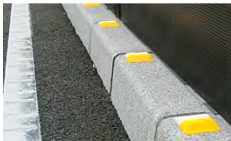
（参考）道路鋸や縁石への反射塗料の設置
