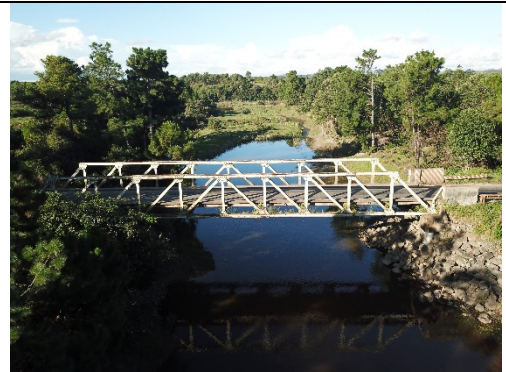
写真12 上流側から望む (2018年7月)
