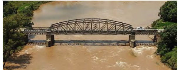
橋梁全景（雨季）
