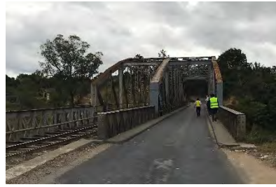
仮補修後（2018年7月）
