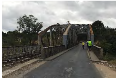
仮補修後（2018年7月）
