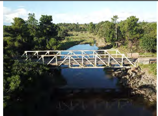
写真12 上流側から望む（2018年7月）
