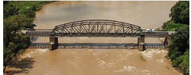
橋梁全景（雨季）
