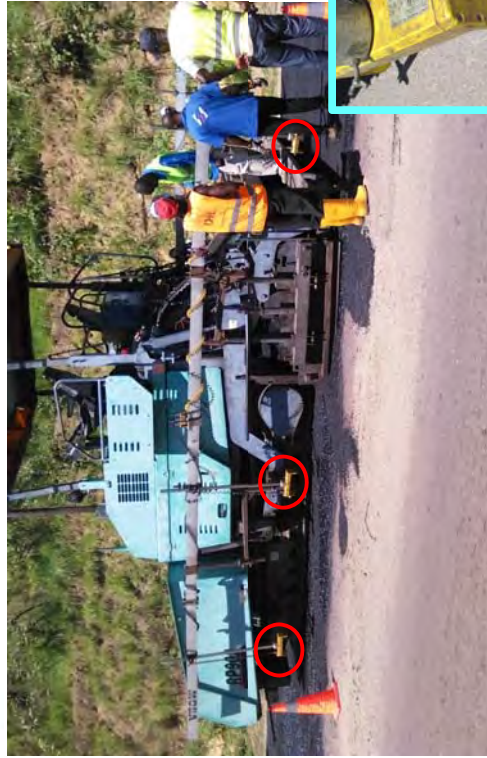
Explication du capteur Sonic
