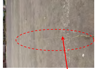
Réflexion des Fissures
