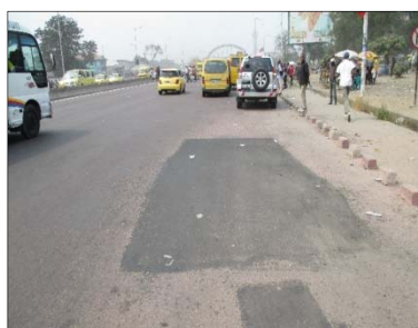
Méthode de reconstruction partielle du revêtement
