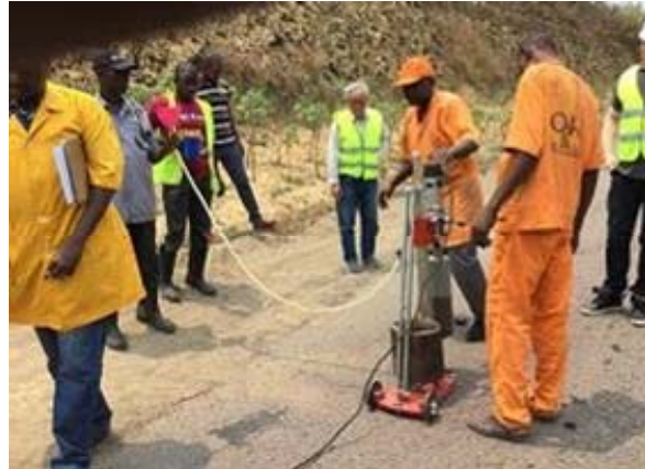
Formation sur le tas sur les travaux de réparation APm Sur la RN43 (Echantillonnage)
