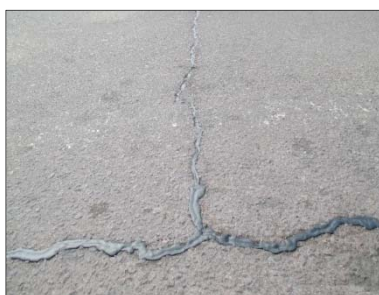
Méthode de scellement de fissures
