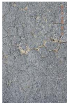
Figure 6.15. Illustration du phénomène de rejet de pompage.
