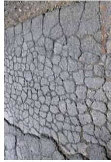
Figure 6.14. Fissures généralisées
