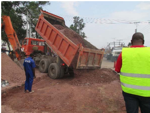
③局部打ち換え工法(1回目)
