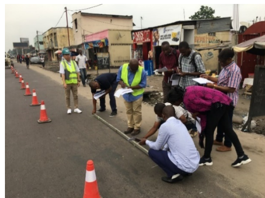
道路点検研修、路面の平坦性計測の実施 (2018/6/14)
