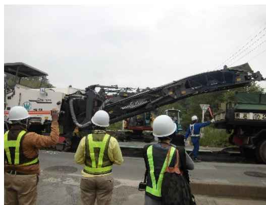
アスファルト舗装補修工事の現場視察
