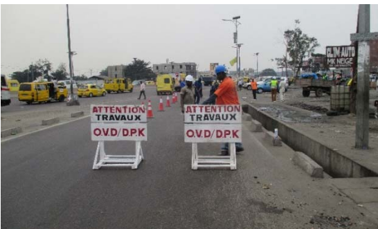
OJT 施工時の安全対策(交通規制) (コンゴ日本大通り)
