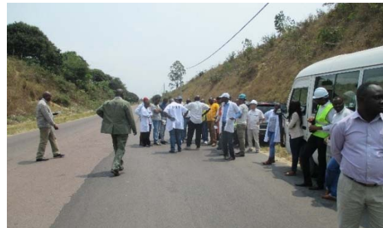
OJT(2回目)サイトのモニタリング視察 (国道 43 号線)
