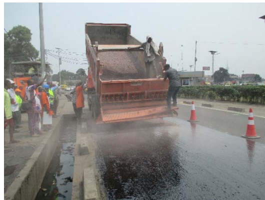
⑦シールコート工法(3回目)
