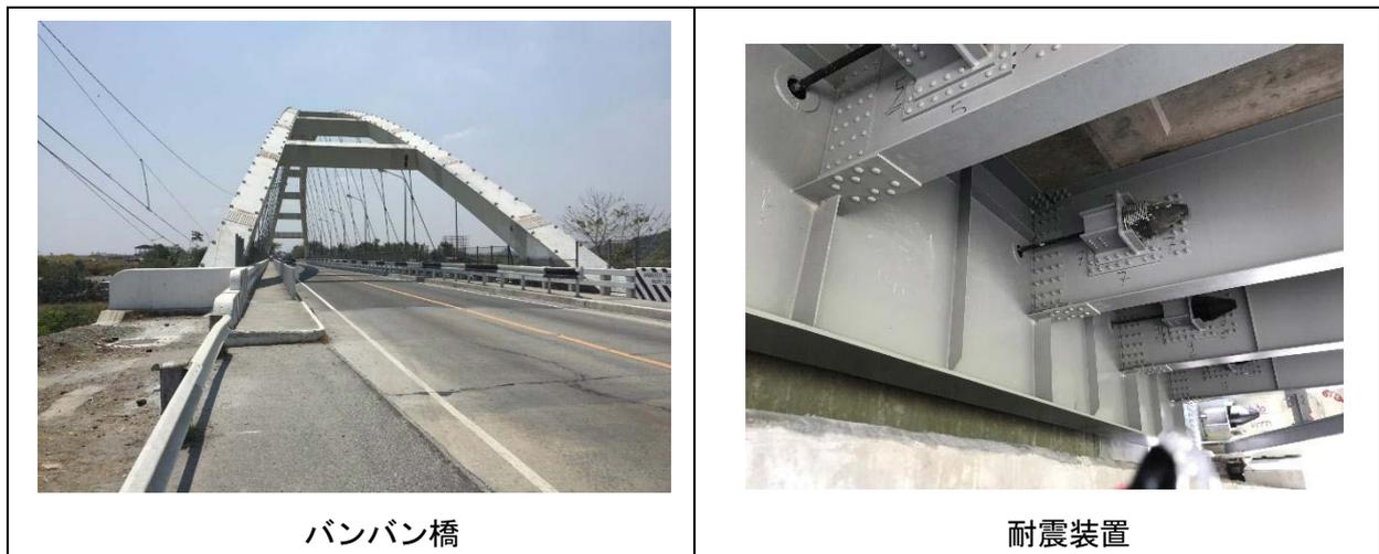
図 1.3.3.4-4 バンバン橋とその耐震装置
