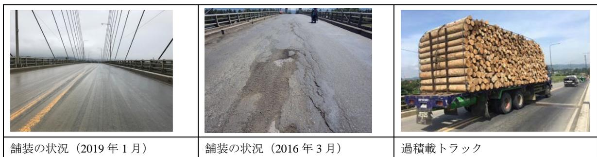
図 1.3.3.4-8 舗装の状況と過積載トラック
