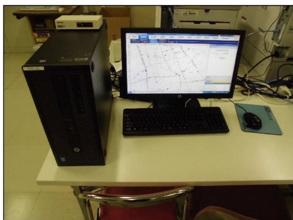
HMI コンソール
