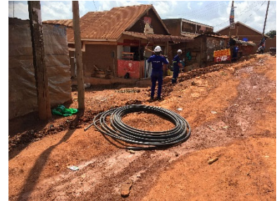
ケーブル地下埋設作業
