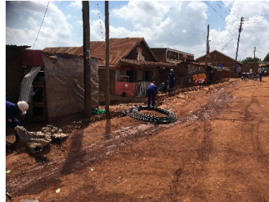
ケーブル地下埋設作業
