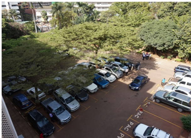
① サイト予定地を上空より見る。現在はアスファルト舗装された平置きの駐車場(約 25 台)となっており、本件では解体・撤去する必要がある。
