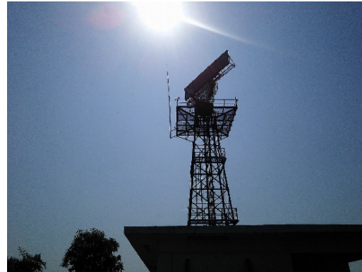
マンダレー国際空港 既設空港監視レーダー／二次監視レーダー (ASR/SSR)
