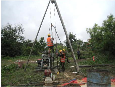
写真 2-11 ボーリング作業
