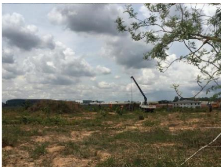
写真 2-1 空港レーダーサイト (1)
