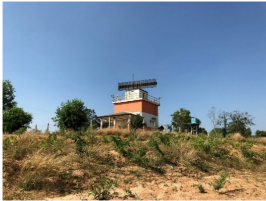
ヤンゴン国際空港 既設二次監視レーダー (SSR)
