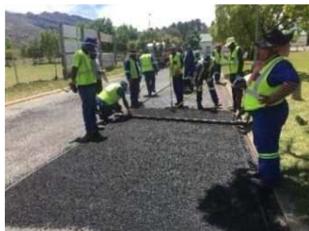
西ケープ州での常温合材工法によるアスファルト舗 装舗設状況 (南ア国 ケープタウン郊外)
