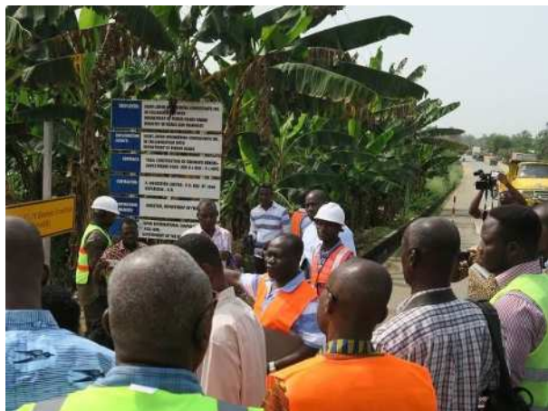
写真 9-6 12月10日の現地視察 セミナー参加者に工 事の内容についてC/P が説明している
