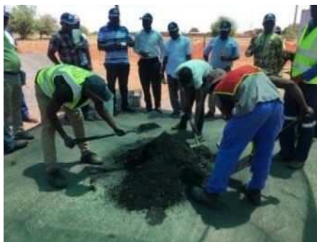
人力での常温合材配合 (南ア国 プレトリア郊外)
