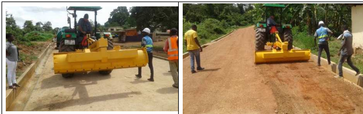
写真-33 牽引式グレーダーの操作研修
