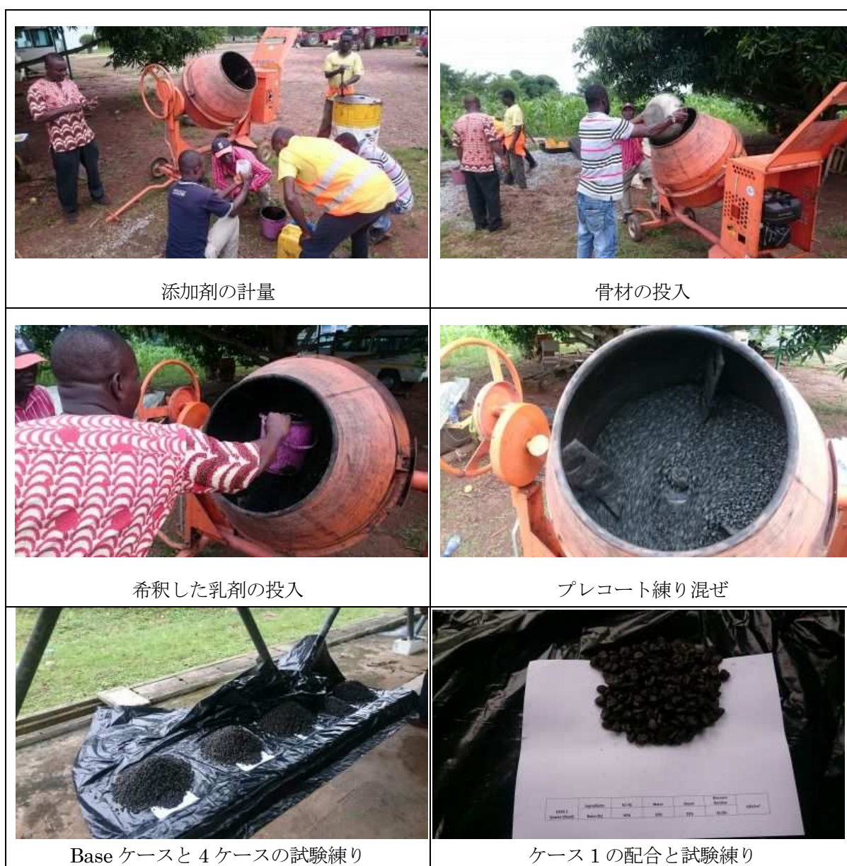
写真-17 今リートミキサーによる骨材プレコートの様子
