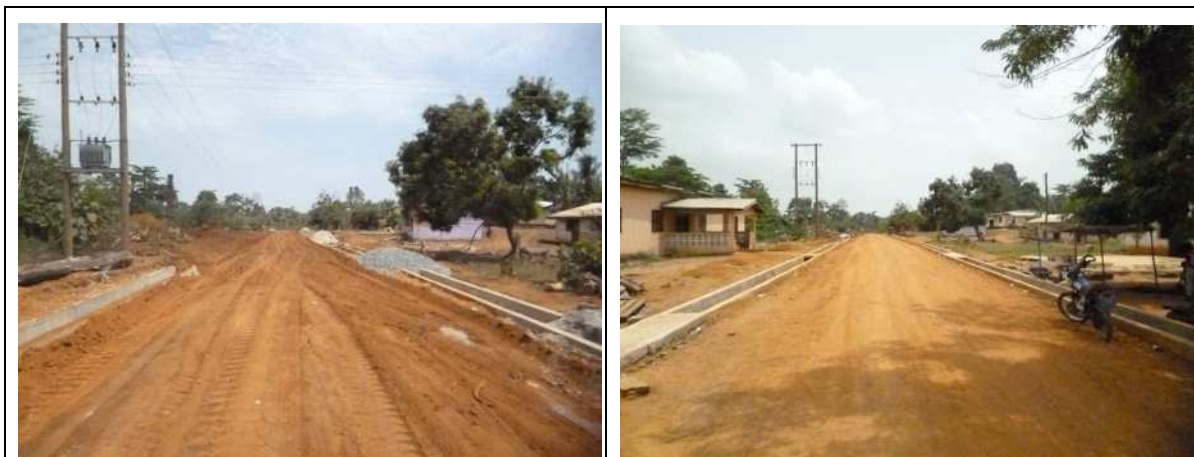
No.3+750 GOG 担当工事である下層路盤が完了
