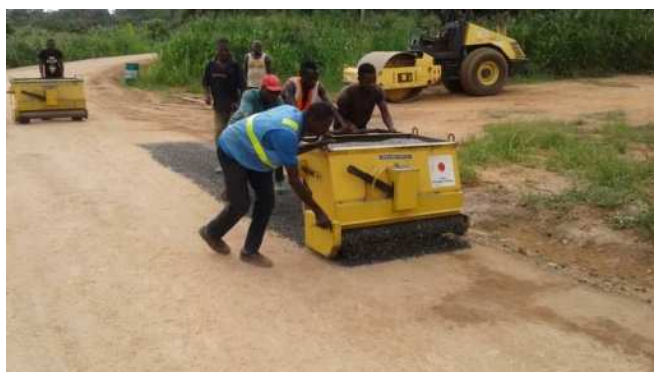
写真-34 チッピーの施工前操作研修
