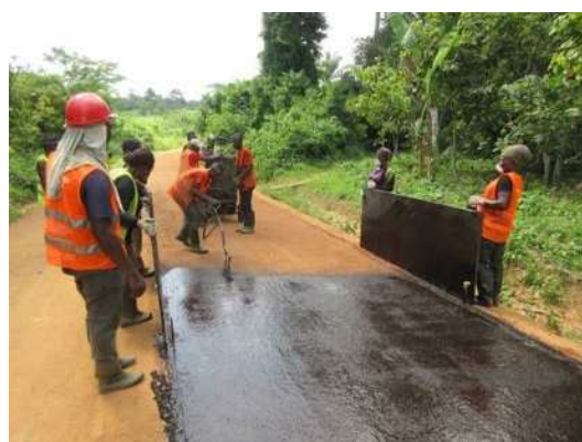
写真- 5 瀝青材の散布
