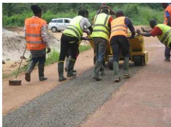
写真-37 チッピー作業状況
