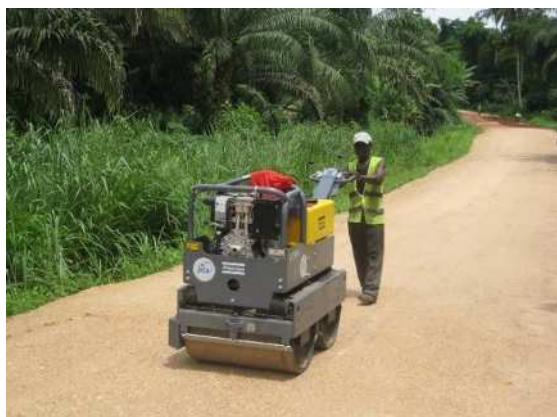
写真-38 作業中のペDESTリアンローラー
