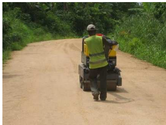
写真-38 作業中のペDESTリアンローラー
