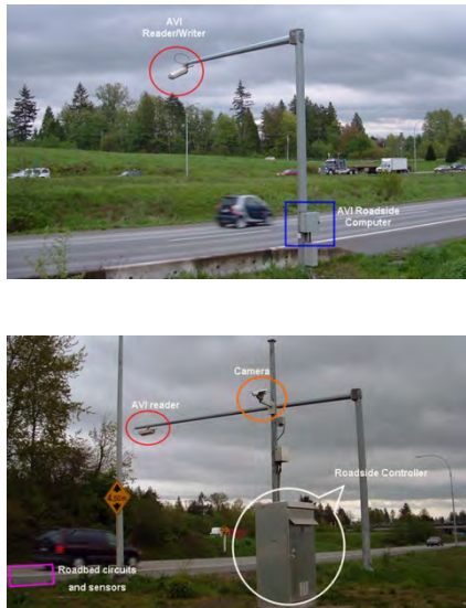
図 5-5 Weigh2GoBC プロジェクトによる WIM の導入事例
