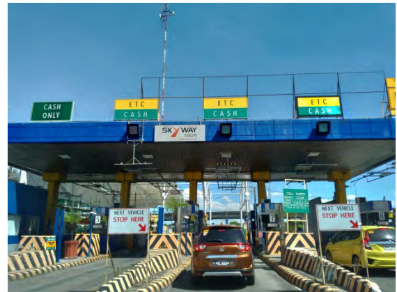
図 3-35 高速道路上でのピーク時のリバーシブルレーンの有用と RFID タグ方式による ETC
