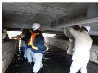
現地視察(電光橋)その1
