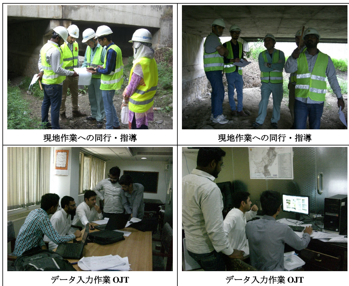
図 2-31 橋梁点検の実施状況
