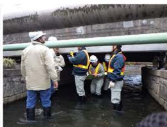
現地視察(電光橋)その2
