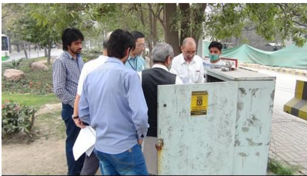
信号制御機の現場研修
