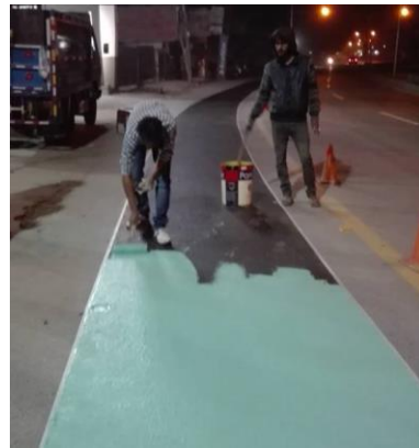
パイロットプロジェクト・カラー歩道ペイント工事
