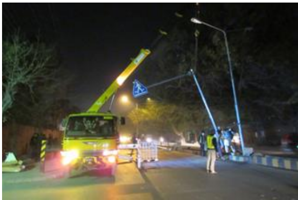
パイロットプロジェクト・自発光式歩行者横断標識設置工事
