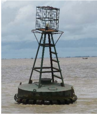
既存灯浮標 (状態が良いため、補修対象)
