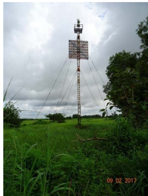
既存タンリンポイント灯台 後灯 (状態が悪いため建替え)
