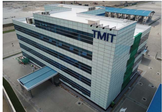
ティラワ ODA 港管理棟屋上 (中継受送信装置設置予定地)
