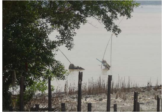
モンキーポイント既存潮位観測標跡地 (2017年12月の船舶衝突による崩壊後) (新規気象海象観測器設置位置)
