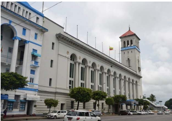
MPA 本社外観 (データ受信装置設置)
