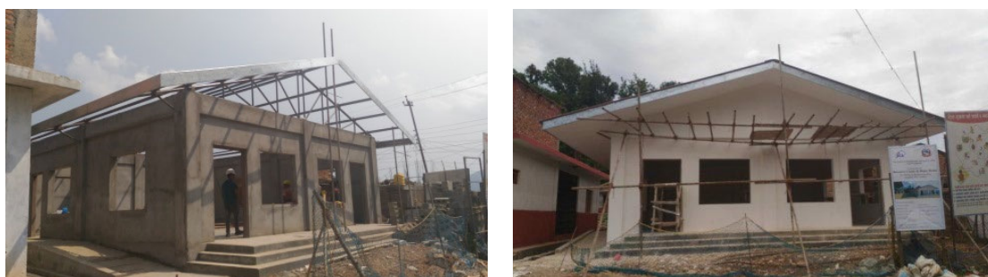
図 2.5.6 Bungkot コミュニティトレーニングセンター建設プロジェクト（QIP-1.04） 工事状況
