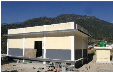
図 2.5.80 優良種子生産改善プロジェクト（QIP-22）Kiwool 工事状況
