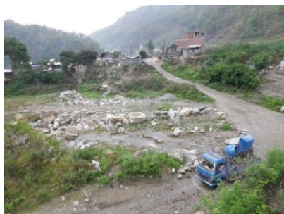
Jhyalla 橋建設予定地
