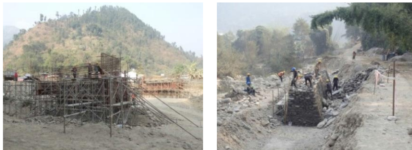
図 2.5.96 Khahare 河橋梁建設プロジェクト（QIP-25）工事状況
