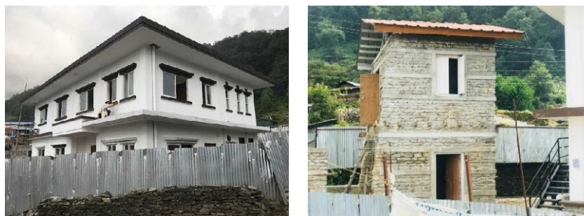
図 2.5.40 Barpak 村開発委員会事務所の再建を通じた社会サービス向上プロジェクト (QIP-12) 工事状況
