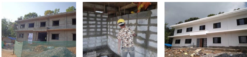
図 2.5.28 農業開発事務所（DADO）の再建を通じた地区における農業活動支援プロジェクト（QIP-6）工事状況
