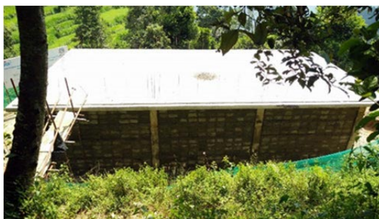
図 2.5.81 優良種子生産改善プロジェクト（QIP-22）Irkhu 工事状況
