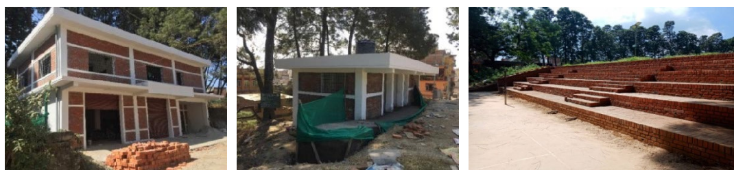
図 2.5.106 Guita Domar (Gokul Chour) 防災公園整備プロジェクト (QIP-27) 工事状況
