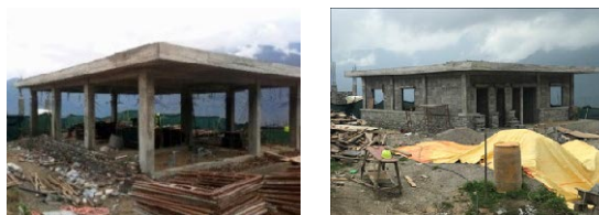
図 2.5.45 女性コミュニティセンターの再建を通じた地方部における女性の社会参加支援プロジェクト（QIP-13）工事状況
