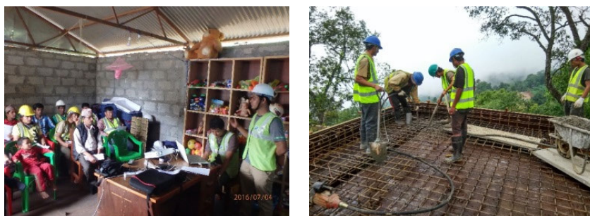
図 2.5.23 Thokarpa 村開発委員会事務所の再建を通じた社会サービス向上支援 プロジェクト（QIP-5）施工技術研修状況
