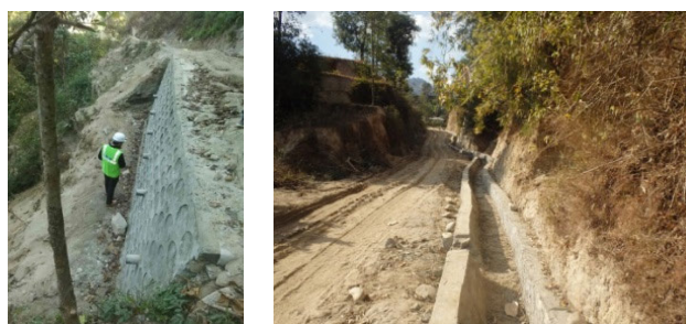
図 2.5.36 Bhotechaur 村落開発委員会および Melamchi における交通機能と灌漑設備の機能回復支援プロジェクト（QIP-9）工事状況
