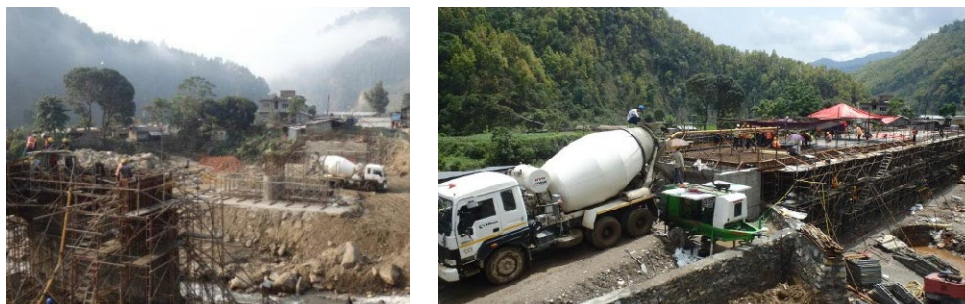
図 2.5.102 Jhyalla 河橋梁建設プロジェクト（QIP-26）工事状況
