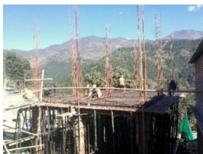
図 2.5.82 優良種子生産改善プロジェクト（QIP-22）Phulpingdanda 工事状況
