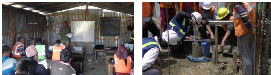
図 2.5.41 Barpak 村開発委員会事務所の再建を通じた社会サービス向上プロジェクト (QIP-12) 施工技術研修状況
