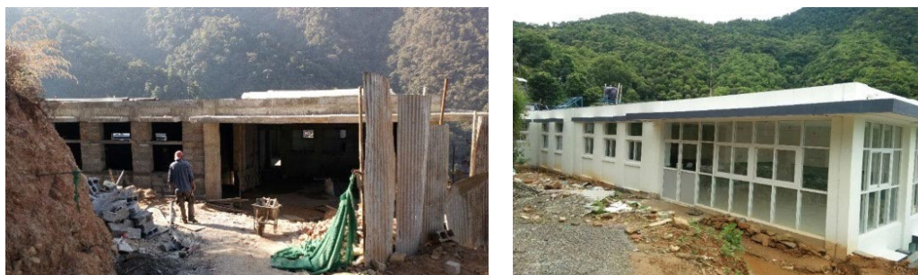
図 2.5.14 Ampipal 病院外来診療部門建物の再建を通じた保健衛生サービスの強化支援プロジェクト（QIP-3）工事状況
