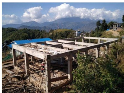
図 2.5.2 Irkhu コミュニティトレーニングセンター建設プロジェクト（QIP-1.02） 工事状況
