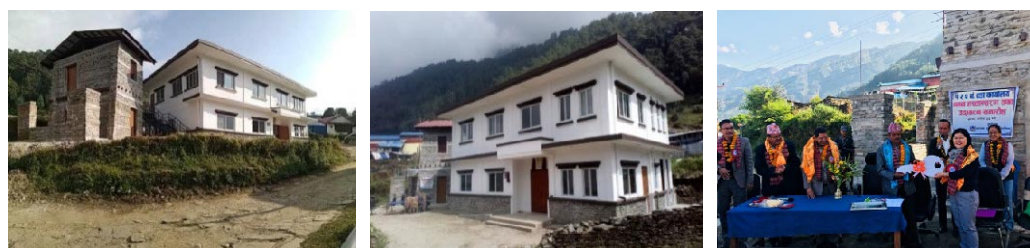
図 2.5.42 Barpak 村開発委員会事務所の再建を通じた社会サービス向上プロジェクト (QIP-12) 引き渡し状況
