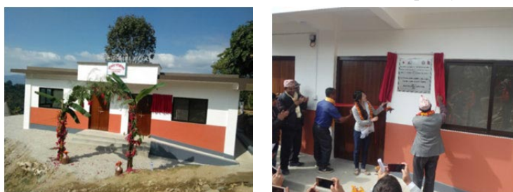
図 2.5.52 Saurpani 村開発委員会事務所の再建を通じた社会サービス向上支援プロジェクト（QIP-16）引き渡し状況
