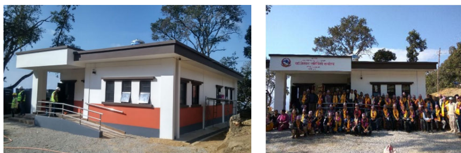
図 2.5.24 Thokarpa 村開発委員会事務所の再建を通じた社会サービス向上支援 プロジェクト（QIP-5）引き渡し状況
