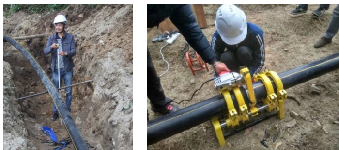
図 2.5.92 MajhuwaNo.1、No.2 導水路改善プロジェクト（QIP-24）工事状況
