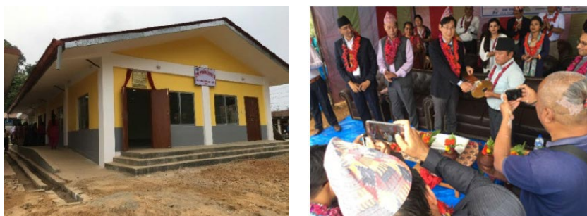
図 2.5.7 Bungkot コミュニティトレーニングセンター建設プロジェクト（QIP-1.04） 引き渡し状況
