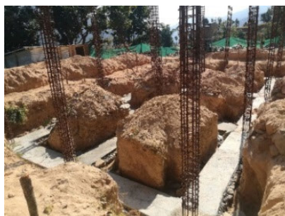
図 2.5.79 優良種子生産改善プロジェクト（QIP-22）Ichok 工事状況
