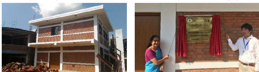
図 2.5.11 女性交流訓練センターの再建を通じた地方部における女性の社会参加支援プロジェクト（QIP-2）引き渡し状況
