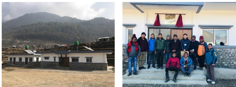
図 2.5.49 ヘルスポストの再建を通じた保健衛生サービスの強化支援プロジェクト (QIP-14) 引き渡し状況
