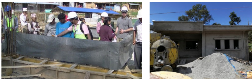
図 2.5.22 Thokarpa 村開発委員会事務所の再建を通じた社会サービス向上支援プロジェクト（QIP-5）工事状況
