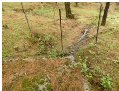
既存パイプ（露出している）
