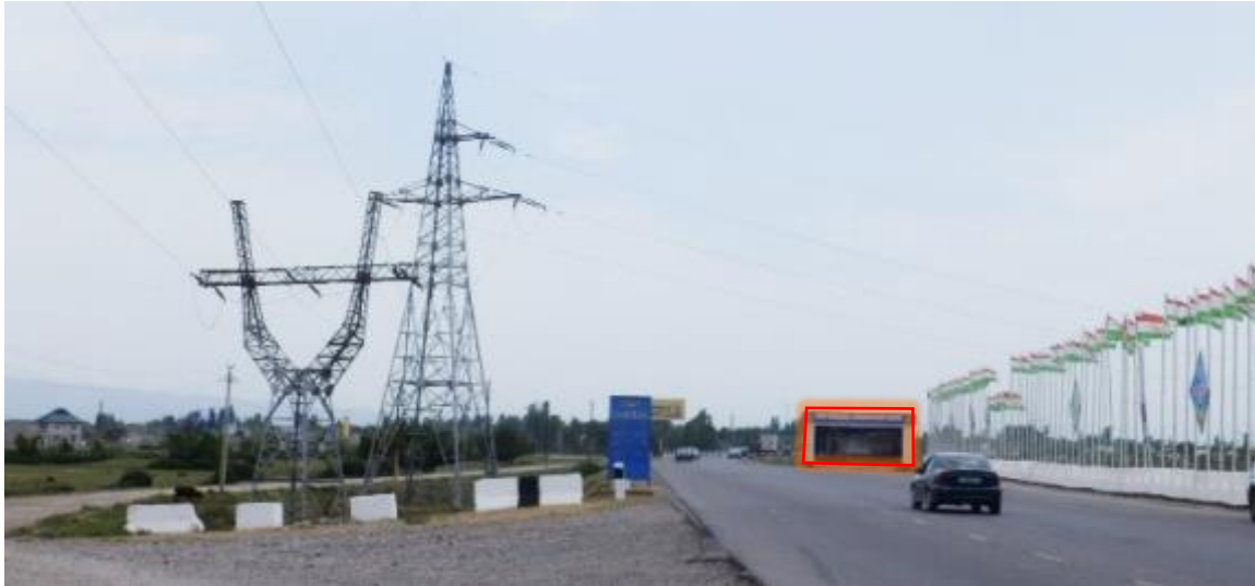
Рисунок 2.2-8 Здание, подлежащее сносу/перемещению
