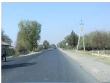
Фото 2.2-1 Состояние существующей дороги
