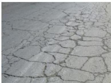
Фото 2.2-4 Крокодиловые трещины
