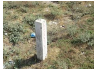
写真 3.2-3 埋設電話線の標示
