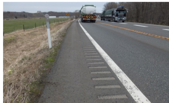
写真 3.2-7 路肩ランブルストリップス
