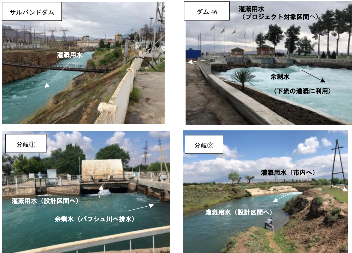
図 3.2-15 ダム・水門施設の状況
