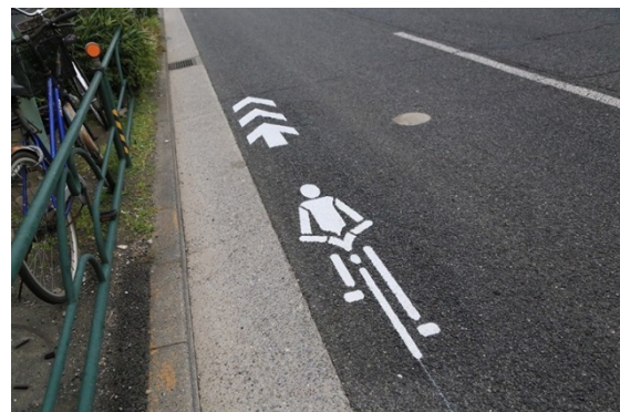
図 3.2-70 自転車専用車線の路面標示
