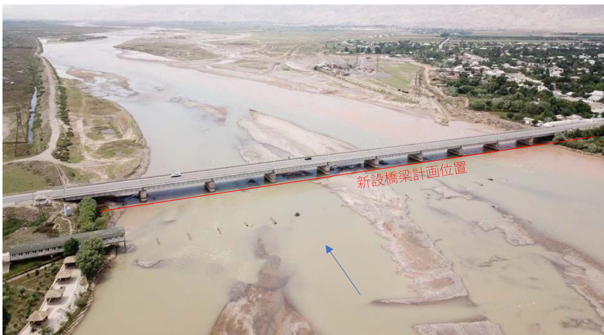
図 3.2-46 新設橋梁付近の断面状況
