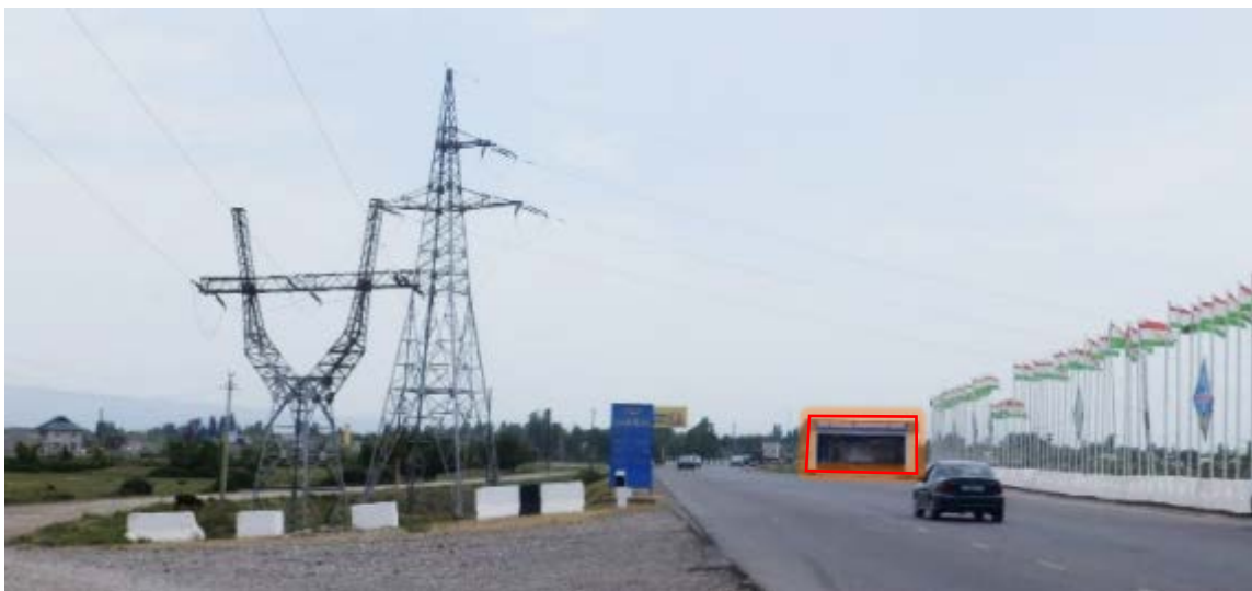
図 3.2-9 取り壊しとなる建屋
