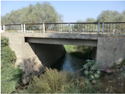
図 2.1-3 既存橋梁 (No.15)
