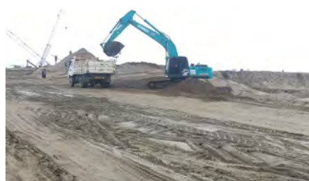
図 3.5.5 地盤改良工 (Phase I)
