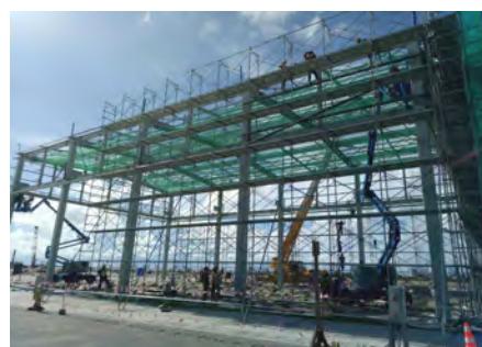
図 3.5.15 鉄骨工事 (Phase I)
