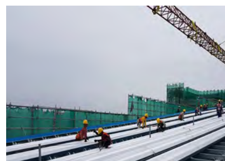
図 3.5.16 鋼製屋根工事 (Phase I)
