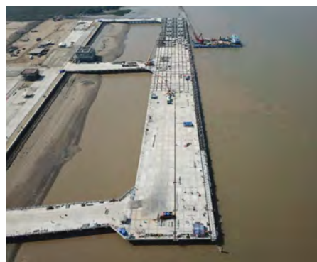
図 3.5.2 栈橋工事（Phase I）
