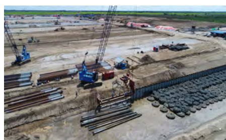
図 3.5.4 護岸工 (Phase I)
