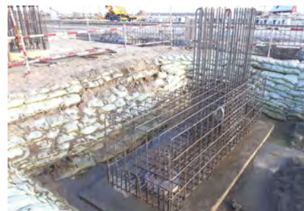
図 3.5.14 鉄筋工事 (Phase I)
