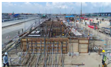
図 3.5.13 型枠工事 (Phase I)
