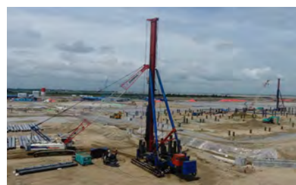
図 3.5.10 杭工事 (Phase I)
