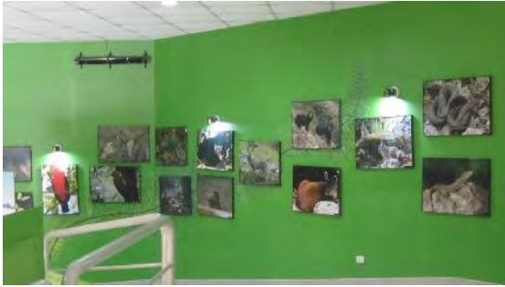
写真-9：壁には照明が設置されているがパネルへの光の当り方にムラがある。
