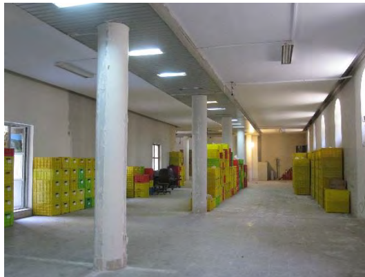
写真-11: 古代イラン博物館地下階 改修後は展示室となる
