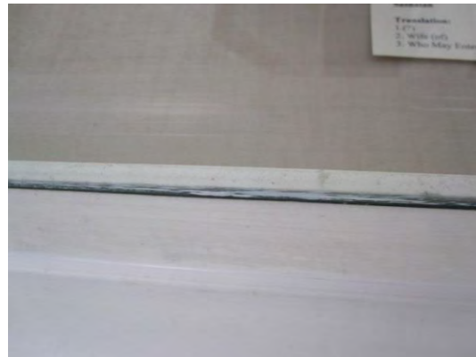
写真-6: 古代イラン博物館 1階展示室 展示ケースに隙間が空いている
