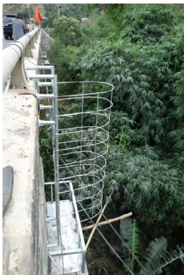
橋梁（タインホア省）での点検通路追加状況
