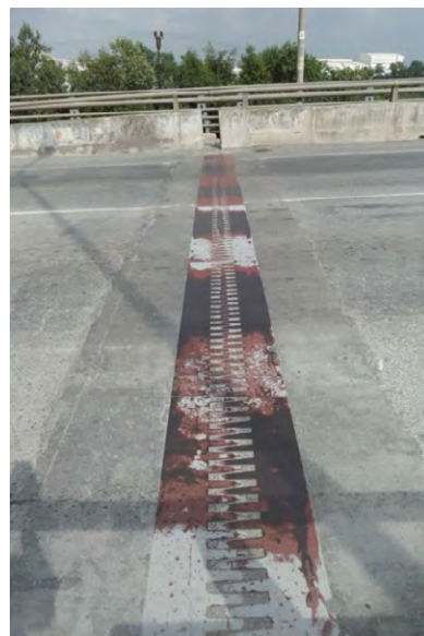
交換された鋼製ジョイント
