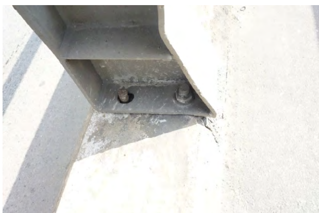
ガードレール接続部
