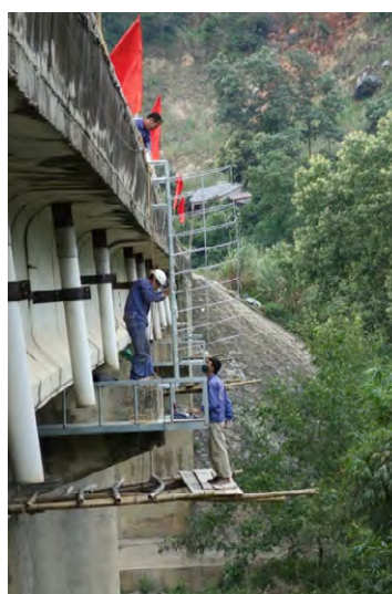
補修工事の実施状況
