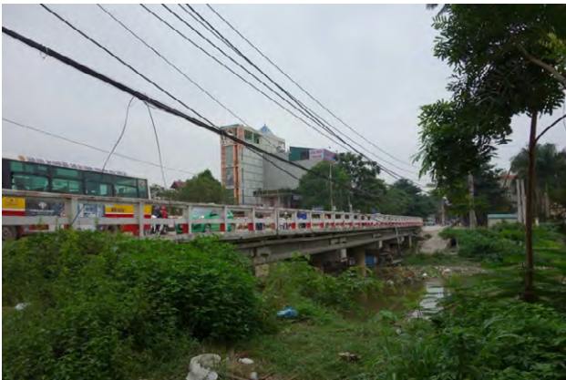
橋梁（タインホア省）でのカーボンファイバーでの補強橋梁全景
