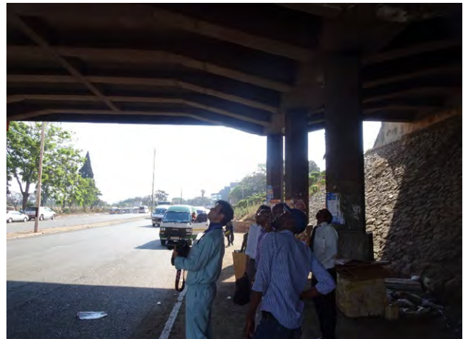
ハラレ市内のコンクリート橋の視察
