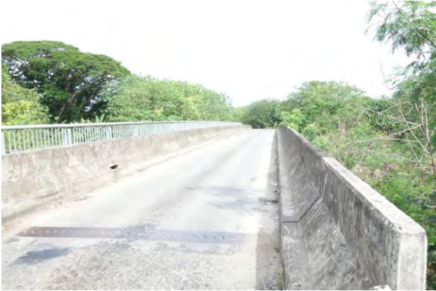
テネルー橋（無償：2006）視察状況
