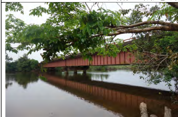
Junk River 橋の状況
