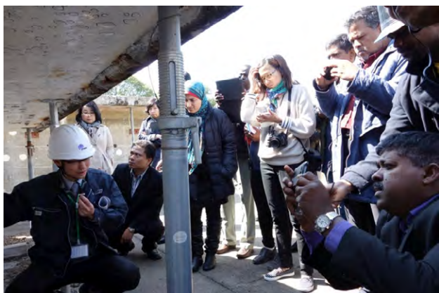
土木研究所での撤去工視察(3/22)
