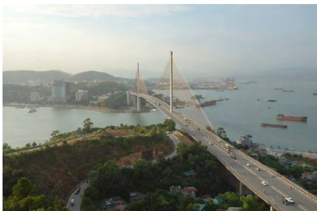
バイチャイ橋全景
