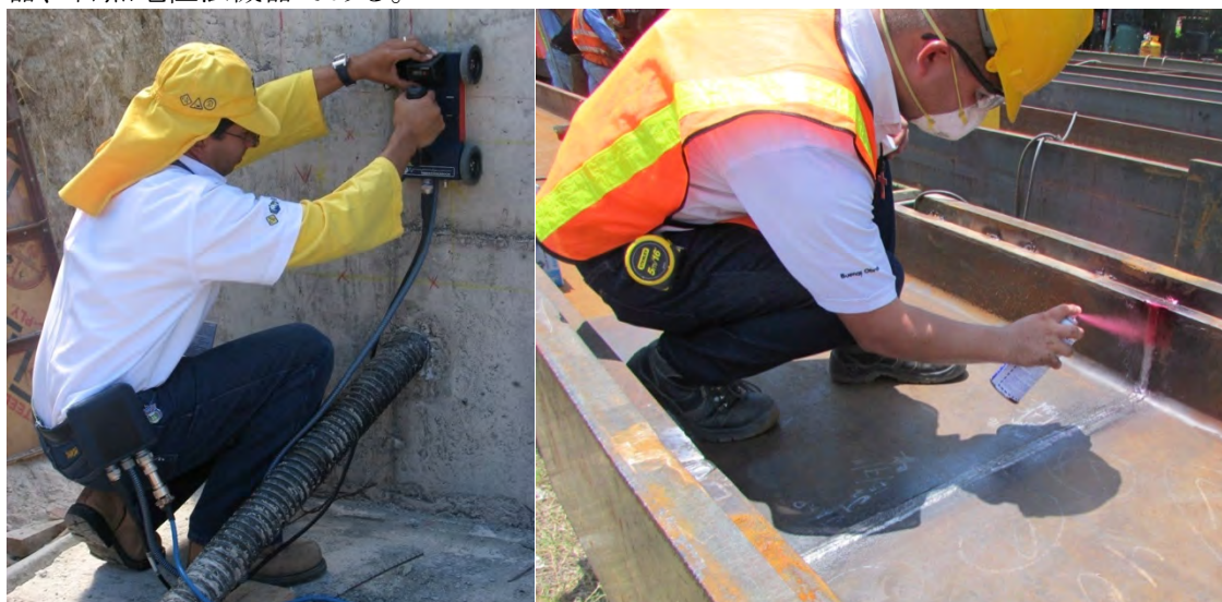
写真 3-1 詳細点検の実施状況
