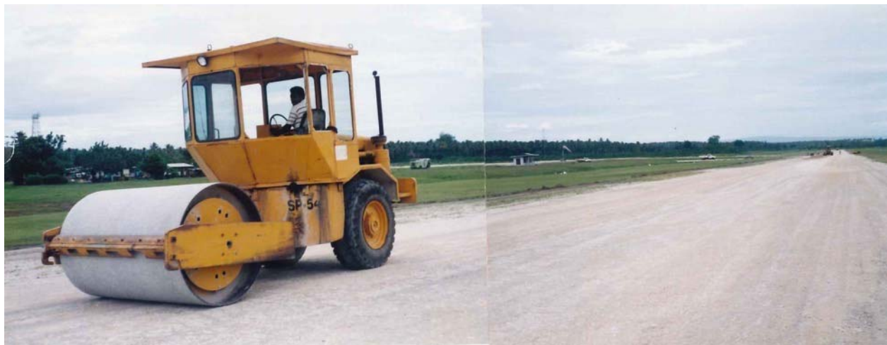
写真3 コーラルを転圧しただけの滑走路 (1995年8月)
