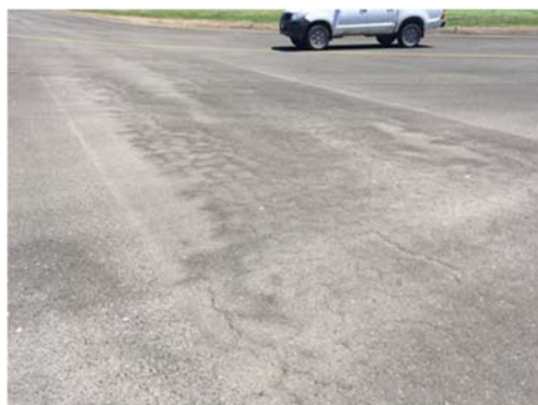
写真9 エプロン舗装の状況
