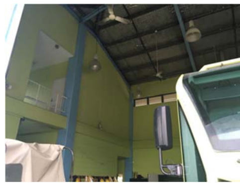
写真 20 消防署内部の壁と天井
