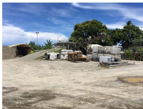
写真2 コンクリート製造所
