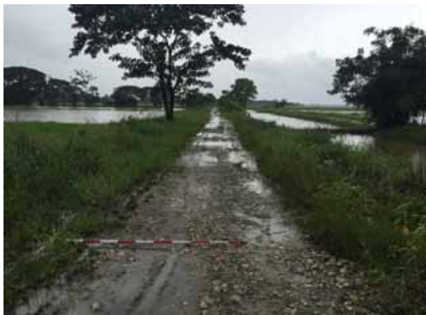
[道路・橋梁 1、シッサリトン村落] 碎石舗装されているが、雨季に泥濁化する箇所が多数あり、通年通行は困難である。
