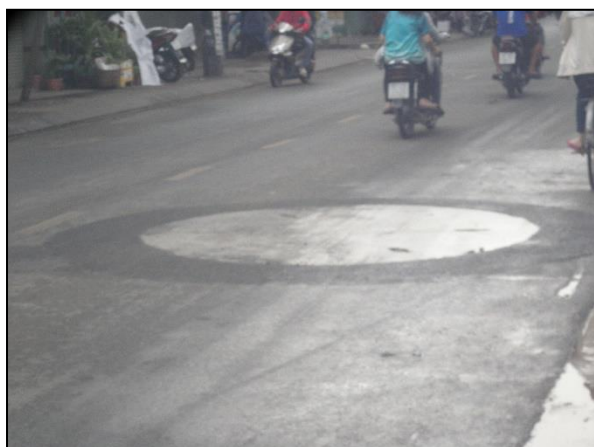
Giếng khoan có vỏ thép (Giếng khoan nối tiếp/Tấm thép dày được lắp đặt)
