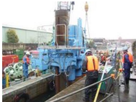
Hình 8.8-3 Phương pháp đóng cọc ống thép (Bản vẽ tham khảo)
