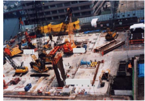
Hình 8.8-1 Phương pháp thi công tường ngầm liên tục (Bản vẽ tham khảo)
