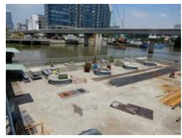
Máy bơm lắp đặt bên bờ trái
