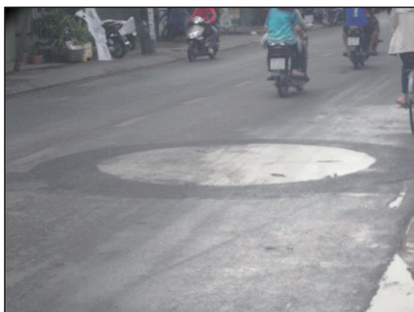
鋼製ケーシング立坑 (通過立坑/覆工板設置)
