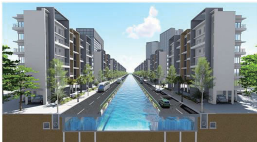
図 2.1-2 鉄筋コンクリート床による整備イメージ図
