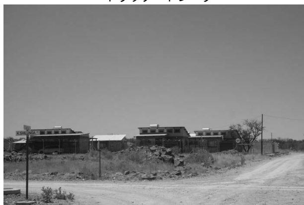
Buitepos 国境施設における国境インフラ（職員宿舎）と 道路の整備状況
