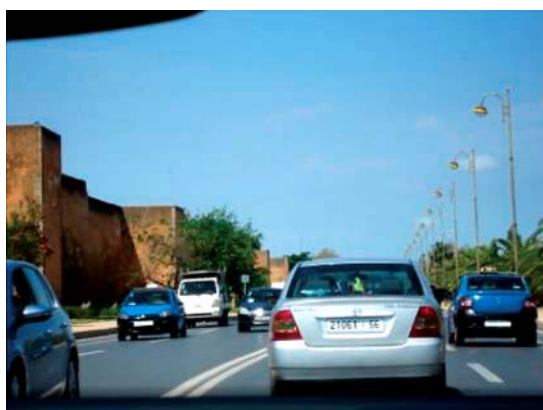
ラバト市内の幹線道路（左側は王宮の城壁）路面の状態は非常に良好。ポッドホール及びその補修痕跡もほとんど見られない（細街路に入るとポッドホールもあるが）。区画線も明瞭であり、全般に舗装打設が新しいように見える。
