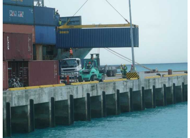
荷役作業の状況
