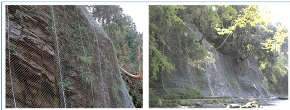
図 2-6: 覆式落石防護網工
