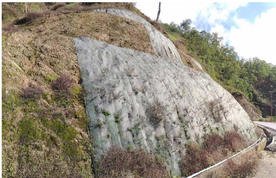
図 1-1: 多機能ネット試験施工
