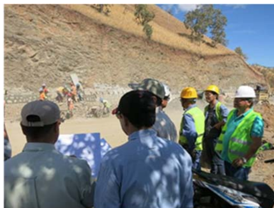
他ドナーによる道路施工の現場視察
