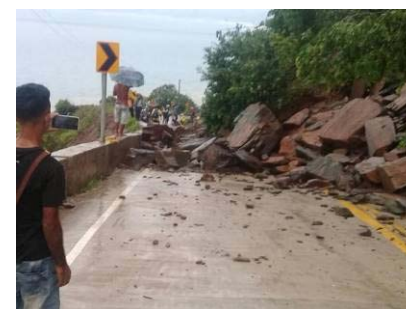
図 2 国道 3 号線カリンバラ地区雨期の土砂災害現場
