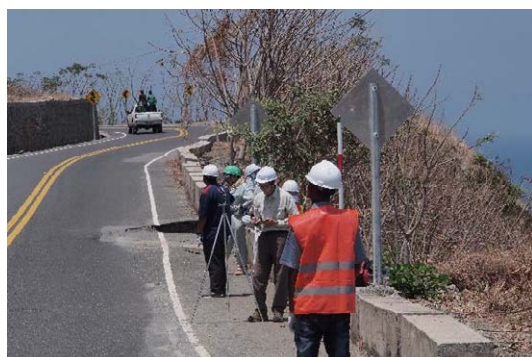
国道3号線KP66+775~999での測量調査
