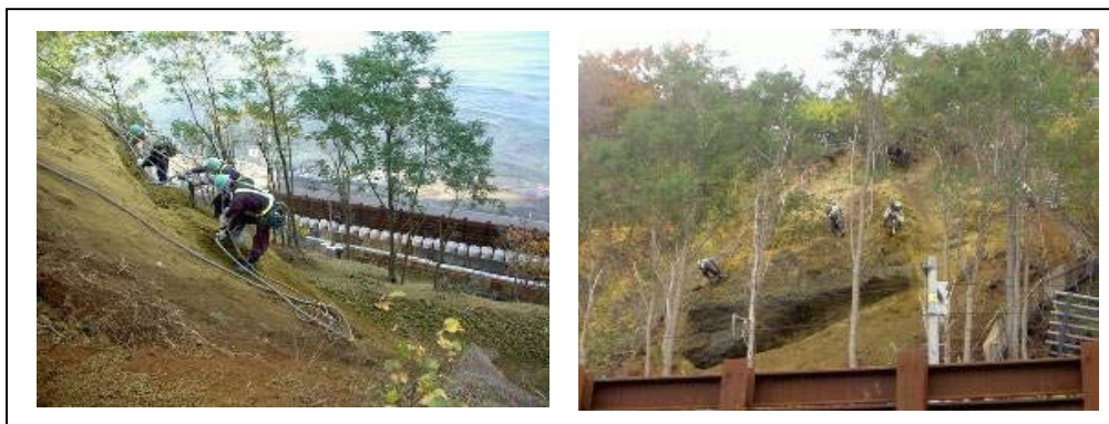
図 2-4: 人力およびハンドブレーカーで破碎、のり切
