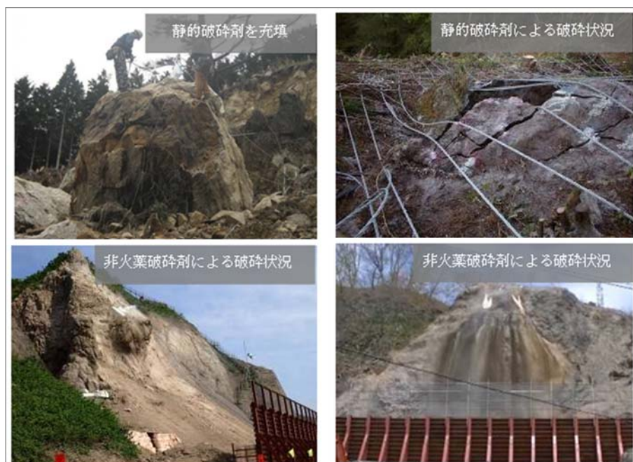
図 2-3: 破碎剤等によるのり切工・岩掘削
