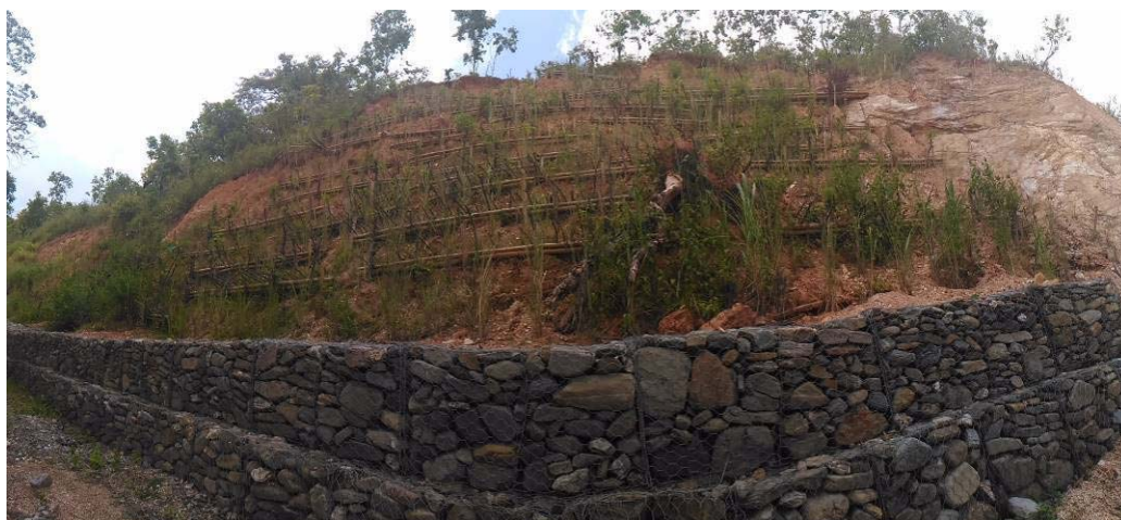
図 1-3: 斜面崩壊対策のための再植栽実施事例
