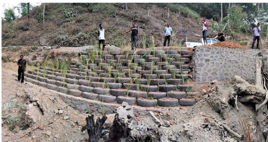
図 1-2: 古タイヤ斜面对策試験施工
