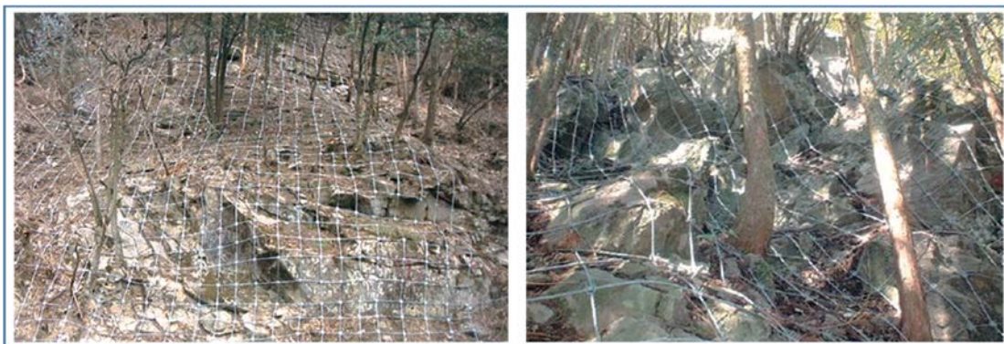
図 2-10: 自然保護型落石防止工(落石防止工)
