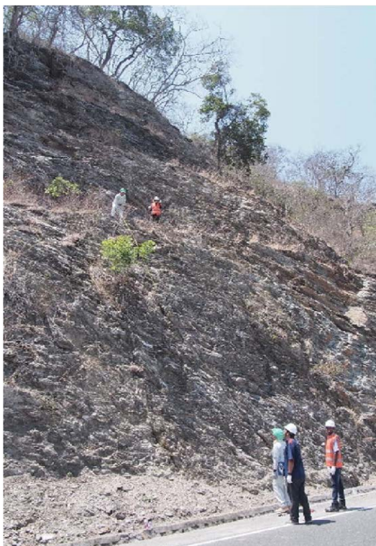
国道3号線KP66+775~999での調査
