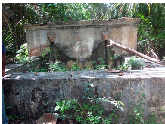
ポルトガル植民地時代に作られた水道 インドネシア軍の撤退時に破壊された
