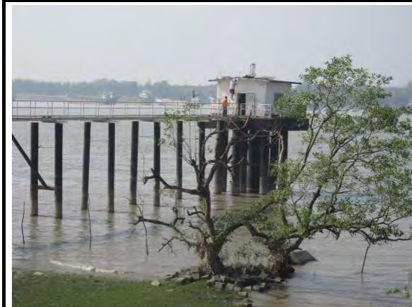
写真-3 プロジェクトサイト 「験潮儀システム」は、チョットグラムの験潮所に設置される。機材は比較的良好に維持管理されているものの、交換部品や消耗品の入手が困難になっている。
