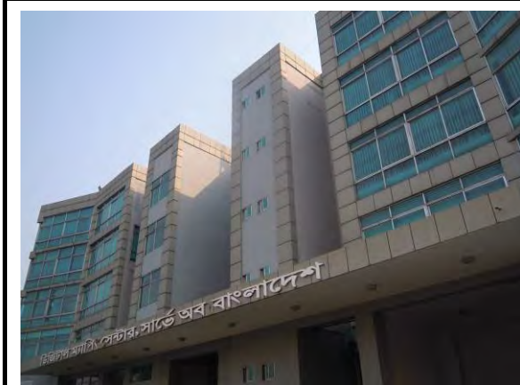
写真-5 プロジェクトサイト ダッカのSOB ミルプール庁舎内に、「電子基準点管理システム」が設置される。
