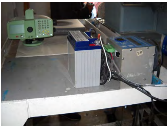
写真-4 プロジェクトサイト 既存のシステムでは、験潮データはダッカから職員が出向いて回収する。機材に不具合があった場合には、発見が遅れ、欠測期間が長引くことがある。
