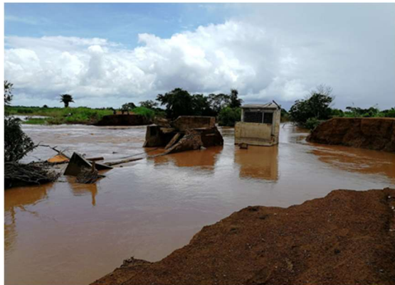
Munda-munda 灌漑地区堤防決壊とポンプ機上被害 (Maganja da Costa 郡 Nante) 2022 年 2 月 27 日
