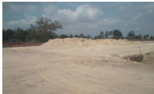
写真 2-2 カルバート周辺の工事（右側）
