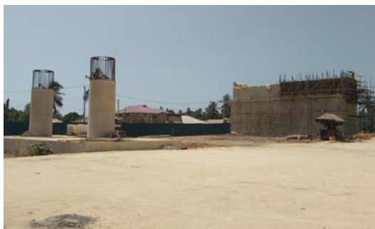
写真 2-1 南部バイパスとアクセス道路の 交差部分
