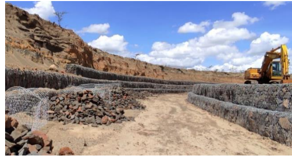
写真 2-6 ナイバシヤ SEZ 用地を横断する小水路で進行中の工事
