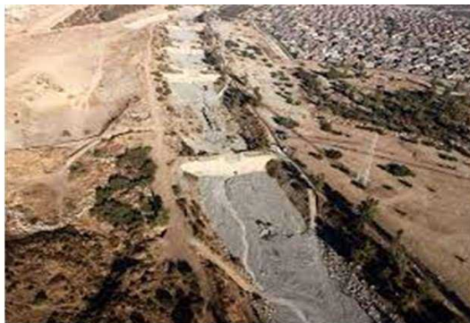
Piscinas decantadoras en La quebrada de Macul
