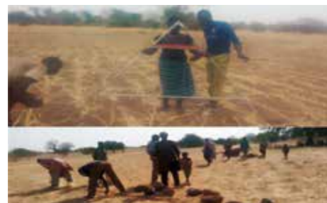
Mise en place de cordon pierreux à l'aide d'un niveau « Grand A »
