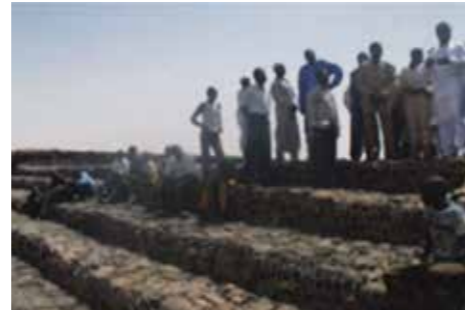
Une retenue d'eau réparée à Bakassomouba
