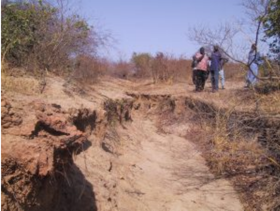
Visite de site de l'érosion Hydrique
