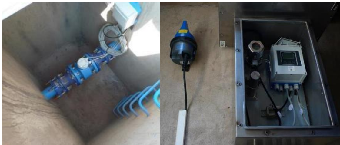
写真 2.2-2 無収水技プロで導入された電磁流量計（左）流量変換機およびテレメータ（右）
