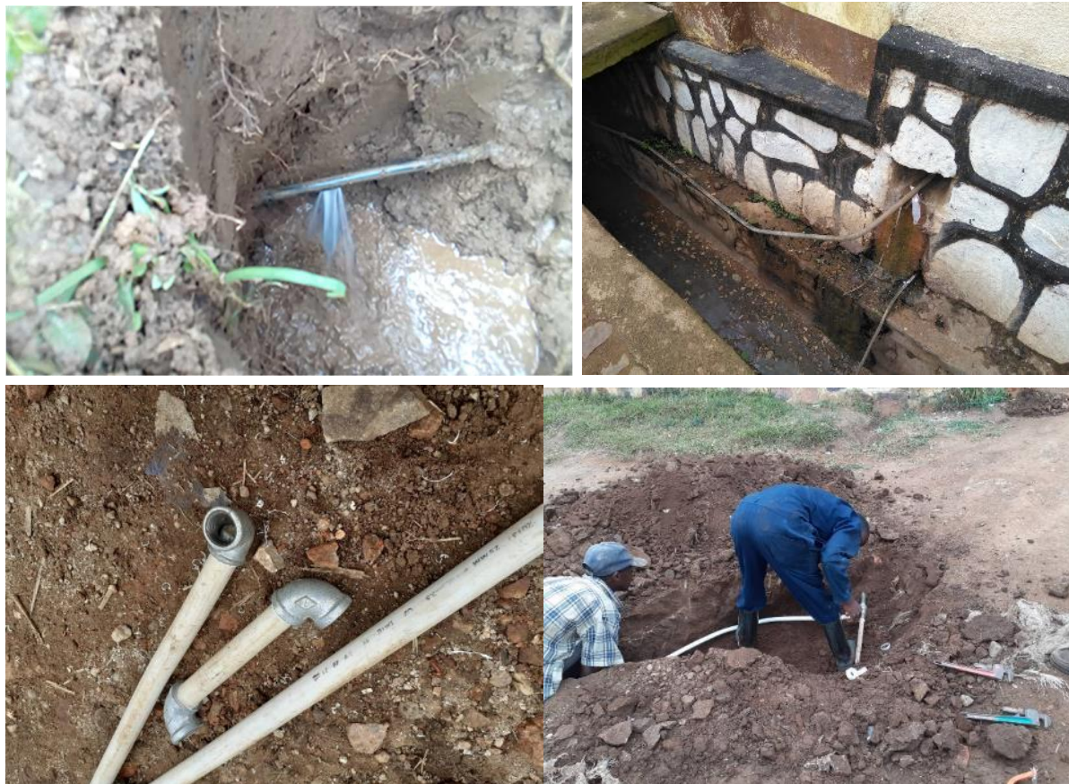
写真 2.1-1 （左上）給水管からの地下漏水の様子（右上）露出配管された GSP（ガス管） （左下）ポリプロピレン管（PP）に铸铁の異形管がねじ切りされた様子（右下）給水管施工の様子
