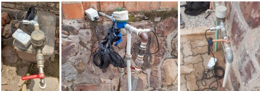
写真 2.2-3 設置した圧力センサとデータロガー
