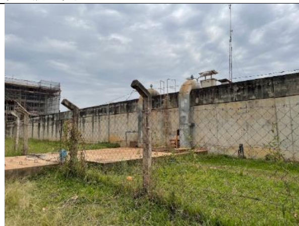
ノトラ配水池
