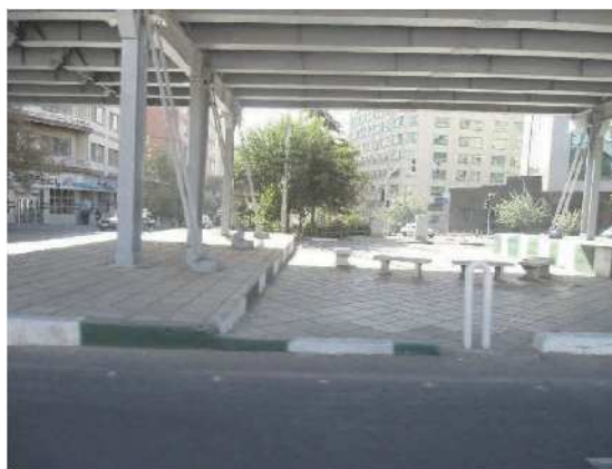
図 2.2.28 既に耐震補強対策が実施された橋梁
