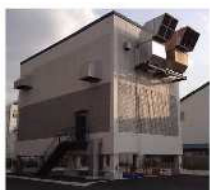
非常用自家発電設備のイメージ
