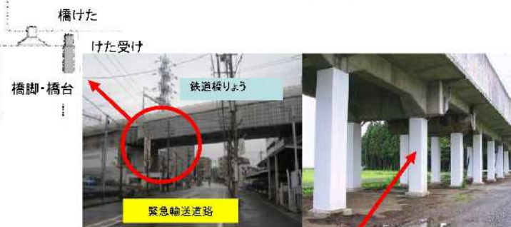
【橋りょうの補強】
