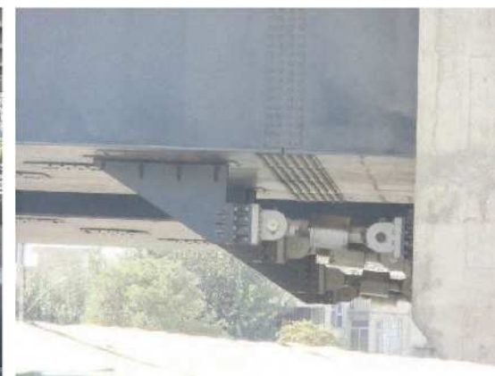
図 2.2.31 桁端部の粘性ダンパーの設置状況
