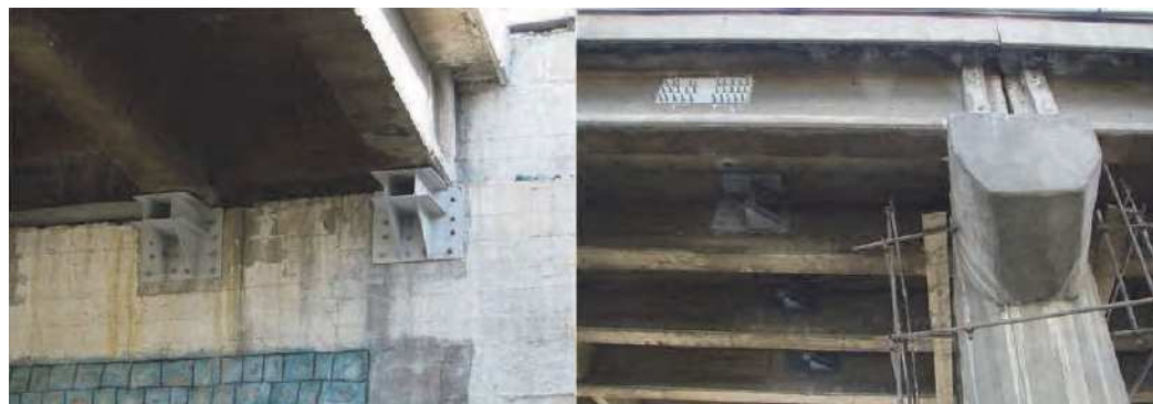
図 2.2.29 落橋防止装置、拡幅装置の設置状況
