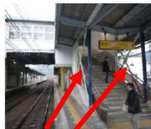
鉄骨ブレース 【橋上駅の補強】
