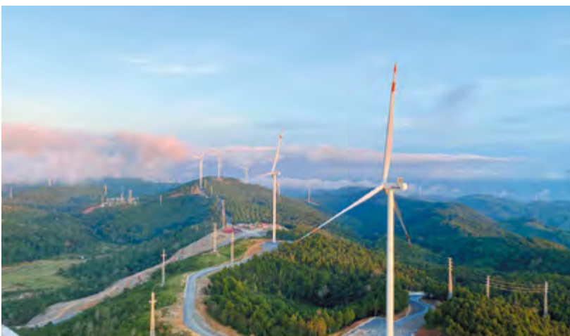
ベトナム：アジア開発銀行、豪州輸出金融公社と協調して、海外投融資により資金協力を行っている、クアンチ省陸上風力発電事業。出資者は、日本の再生可能エネルギー発電事業者である株式会社レノバと地場の電気事業者であるPC1 Group Joint Stock Company。2021年10月に完工、発電を開始した[写真：株式会社レノバ]
