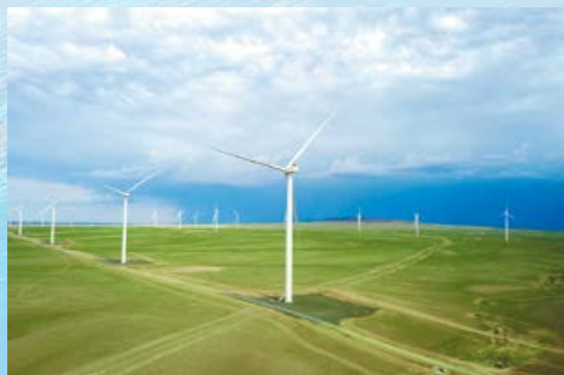
モンゴルで2番目の自然エネルギープロジェクトとして民間事業者により実施されるツェツィー風力発電所に、欧州復興開発銀行と協調して海外投融資による支援を実施
