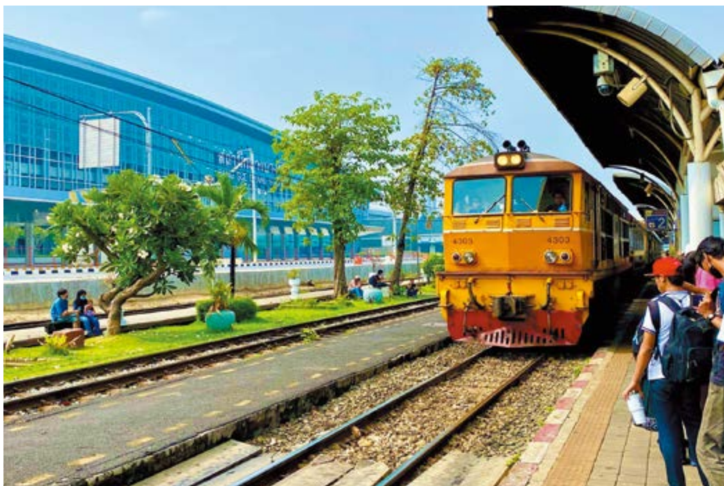
タイ：円借款事業「バンコク大量輸送網整備事業(レッドライン)」で建設し、2021年8月に開業したパンスー中央駅(左側)と既存のタイ国鉄のパンスー駅(右側)。バンコクの新たな玄関口となる予定の同駅周辺ではスマートシティ構想があり、JICAもこの構想策定と推進に協力している
