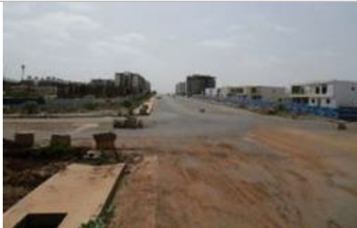
建設サイト周辺
