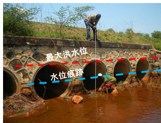
図 3-2-34 幹線道路の横断箇所の状況
