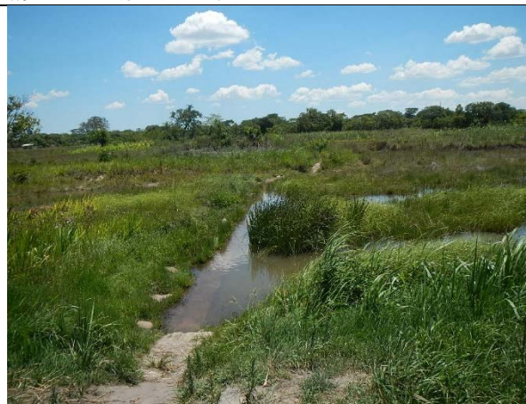
既存ため池洪水吐 越流堰長 20 m。種子生産ほ場に用水を供給するのに新設した取水工では高低差が得られないため、ため池洪水吐からの越流水を土水路で送水している。
